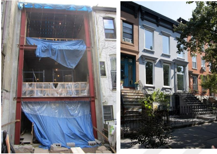
Resim 3.42. Cephe yenilenmesi görünümü (URL-77)
