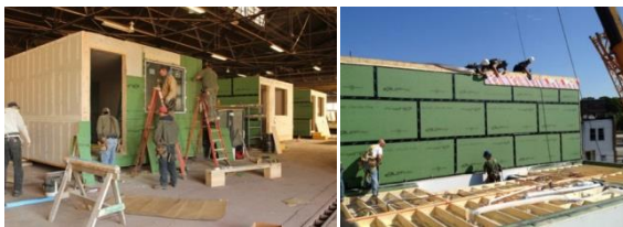
Resim 3.25. Ahşap prefabrik yapıların fabrikada yalıtılıp yerinde hava sızdırmazlık malzemesinin uygulanışı (URL-64)
