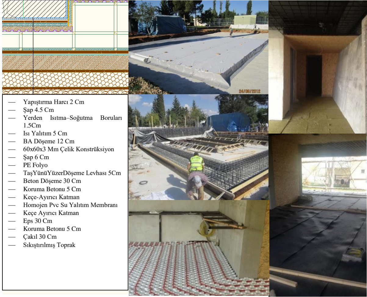
Resim 4.5. Temel-duvar yalıtım-havasızdırmazlık uygulamasının yapılışı (URL-90)
