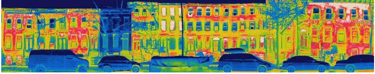
Resim 3.41. Yapılan termografik çekim sonucu olumlu havasızdırmazlık sonucu görünümü (URL-72)
