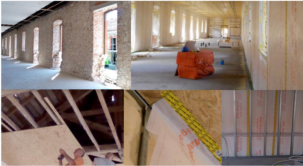
Resim 3.52. Pencere-duvar-tavan detayı-yalıtım – hava sızdırmazlık (URL-85)
