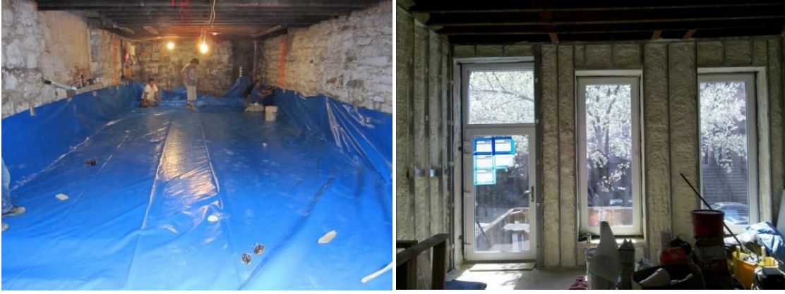
Resim 3.43. Bodrum kat havasızdırmazlık membranının ve iç mekan yalıtım uygulaması (URL-77)
