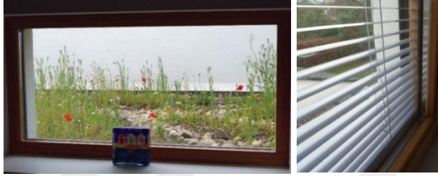
Resim 3.35. Yaşayan çatı görünüşü ve entegre jaluzili pencere (URL-71)
