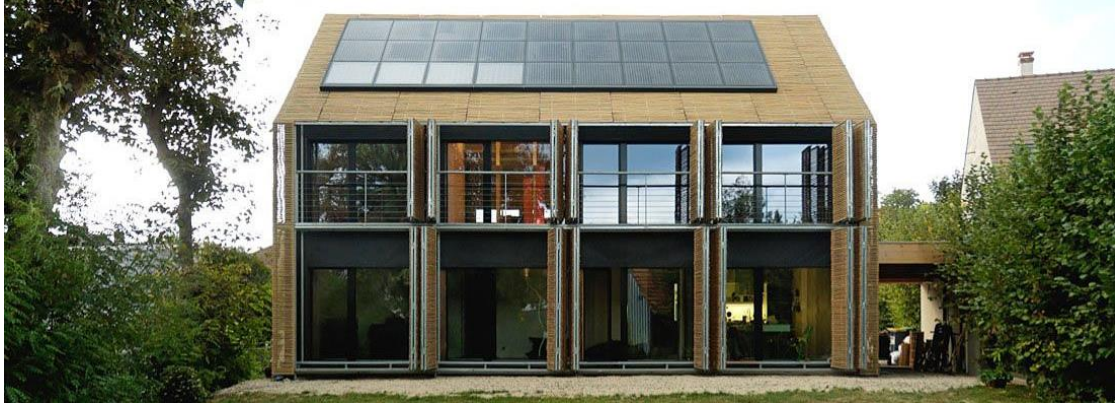
Resim 3.19. Hareketli panjur sistemi ve fotovoltaik paneller (URL-56)
