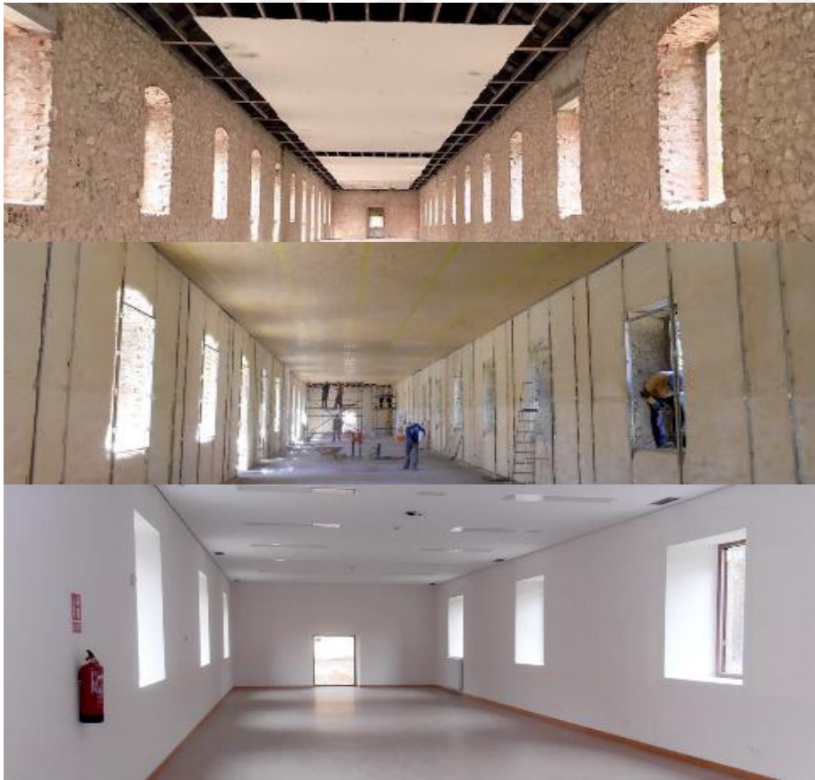
Resim 3.54. Eski yapı duvar-çatı-pencere mevcut durumu-yenileme aşamasında çatı-duvar-döşeme renovasyonun gösterimi (URL-85)
