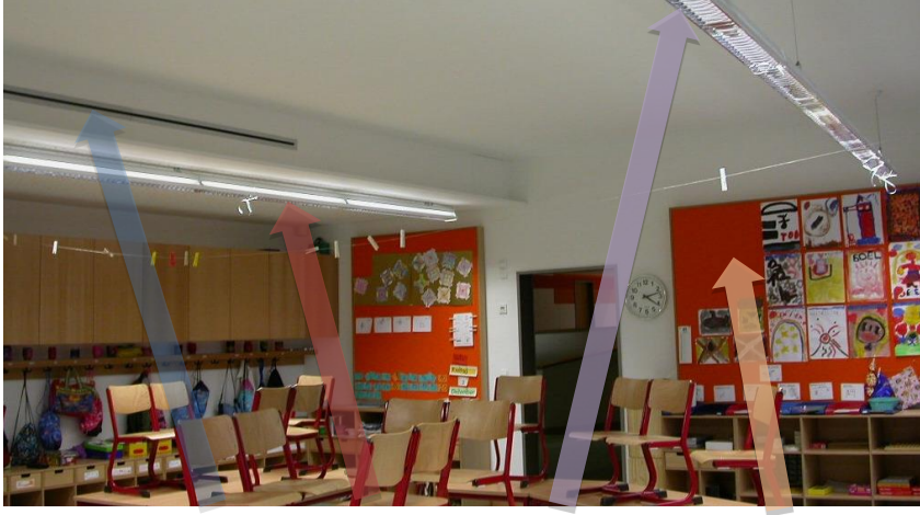
Resim 3.7. Havalandırma-düşük tavan-verimli aydınlatma-akustik duvar (URL-36)
