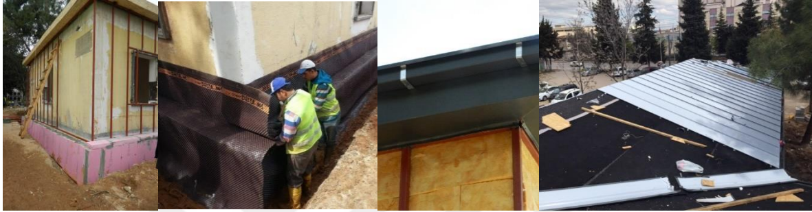
Resim 4.14. Bina dış mekan-temel yan duvarlar yalıtım uygulaması-detayları (URL-95)
