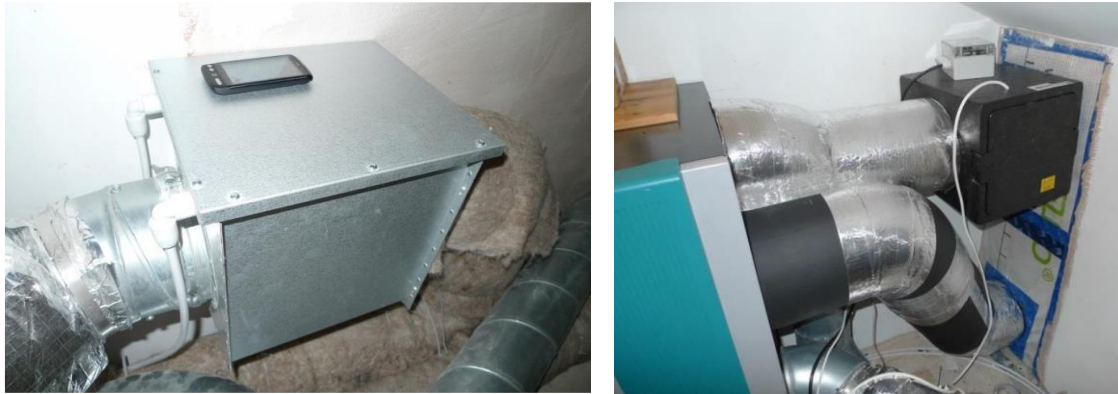
Resim 3.37. MHVR kanallı ısıtıcı ve yalıtımlı besleme kanalları ve soğuk kanallar (Passive House Institute, 2015b)
