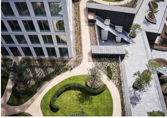
Resim 3.3. At a Glance Binası-Lüksenburg (Üstten görünüş) (URL-13)
