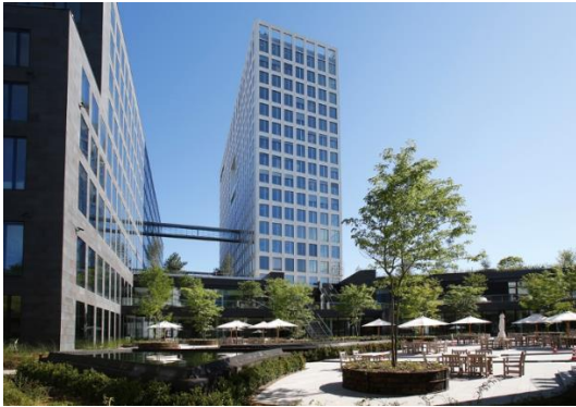
Resim 3.2. At a Glance Binası-Lüksemburg, bahçeden görünüş (URL-13)
