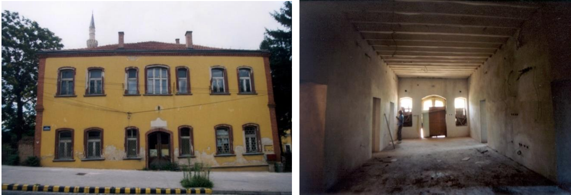
Resim 5.16. Telgrafhane binasının dış ve iç görünümü (2005)
