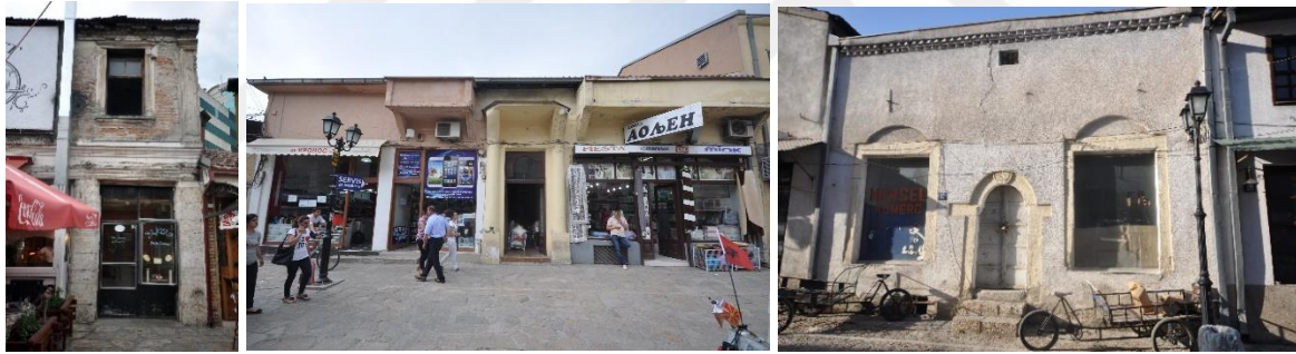
Resim 7.9. Çarşıda farklı yapı sistem ve malzemesiyle yapılmış yapı örnekleri
