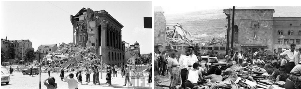
Resim 4.5. Yıkılan Ordu Evi (sol) ve deprem anı durmuş saatiyle yıkılmış hâli günümüzde anıt olarak korunan istasyon binası (sağ) (Kurir, 2012)
