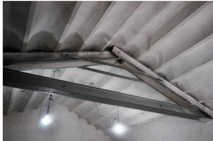
Şekil 7.5. P.6336 ve çevresindeki yapılarda volta döşeme kullanılmıştır.
