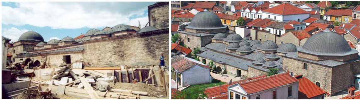
Resim 5.10. Davut Paşa Hamamı restorasyon çalışmaları ve genel görünümü (sağ-T. Yılmaz)
