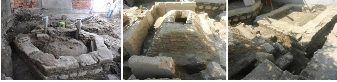
Resim 4.17. Meddah Baba Türbesi kazı çalışmasında ortaya çıkarılan türbe temeli
