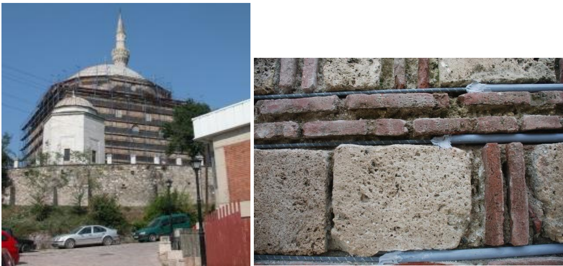
Resim 4.12. Mustafa Paşa Camii restorasyon projesi ile beden duvarları güçlendirilmiştir (Restorasyon Projesi: I. Aksulu, M. Z. İbrahimgil, Ö. Sağiroğlu, E. Ö. Yazgan, T. A. Tülücü)
