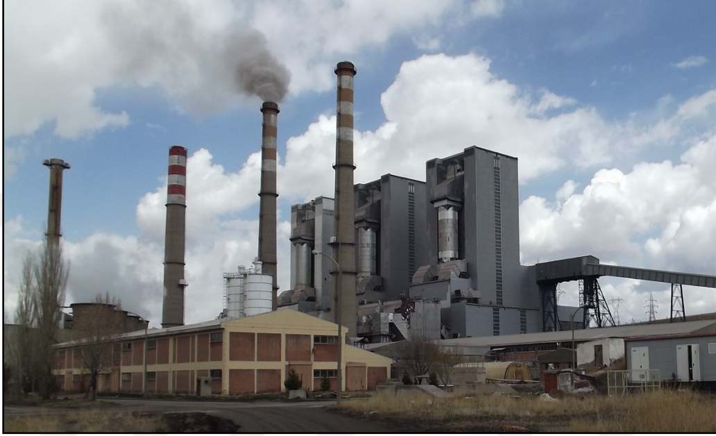
Fotoğraf 3.11: Kangal Termik Santrali'nden Bir Görünüm.
