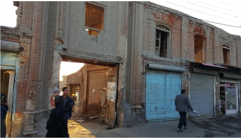
Resim 4.56. Binada tahribat Ruhizinde kervansarayı, 2017 (İraj Mohseni Arşivi)
