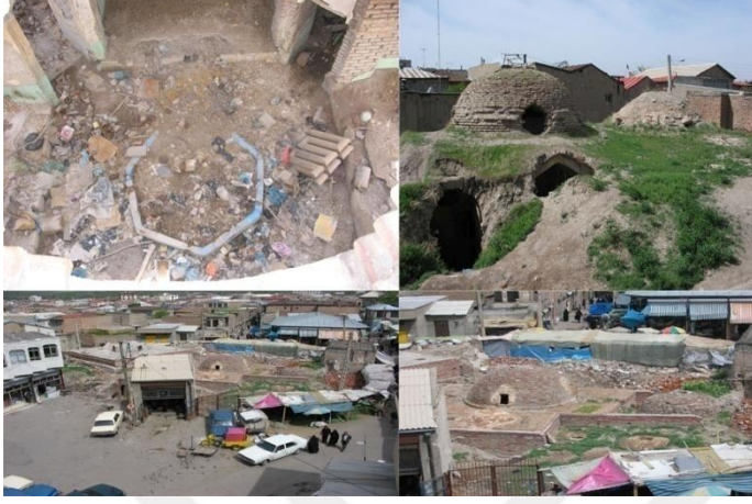
Resim 4.72. Nasîrüddin Tûsî hamamı onarımdan önce, 2005 (Meraga Belediyesi)
