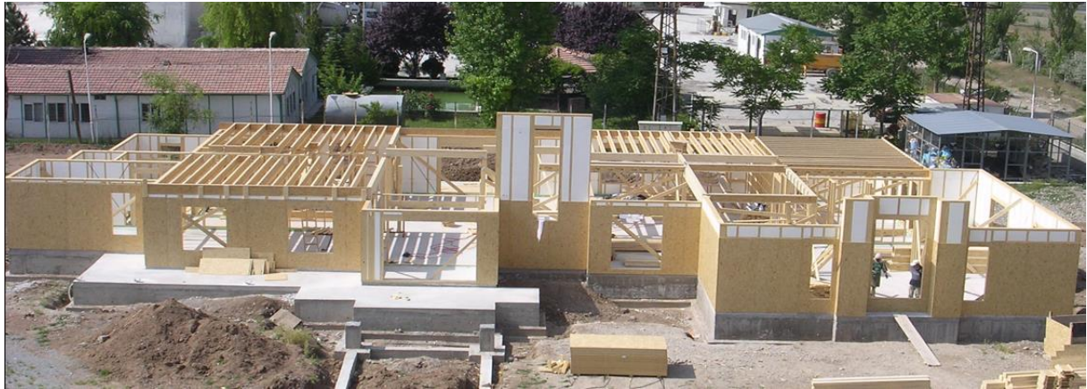
Şekil 3.3. Panel bileşen sistemli ahşap yapı örneği
