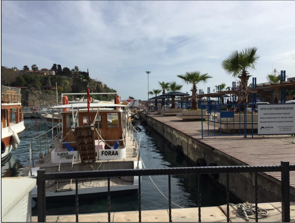
Resim 4.22. Yat Limanı Fonksiyonu Verildikten Sonra İnşa Edilen Beton İskele (Türkoğlu, H., Arşiv 2018)
