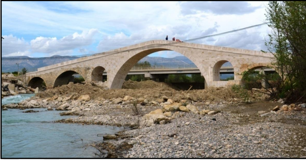
Fotoğraf-31: Restore Çalışmaları Devam Eden Tarihi “Kadıköy Köprüsü”
