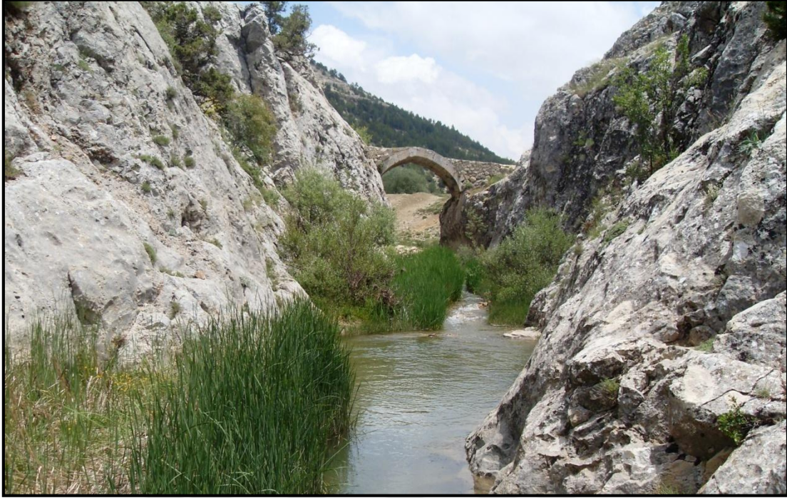
Fotoğraf-59: Sögütözü Köprüsü
