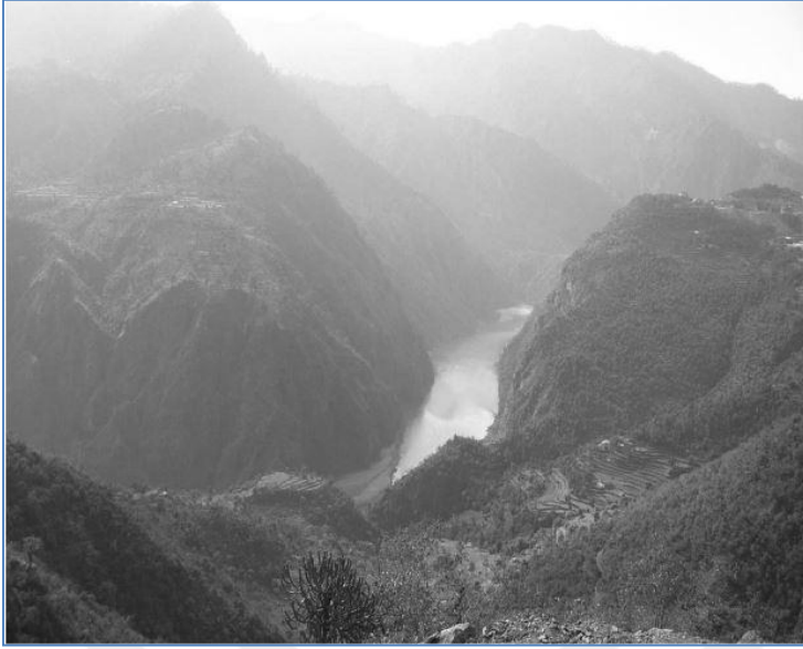
Şekil 4.11. Köprü inşaa alanını gösteren fotoğraf [98]
