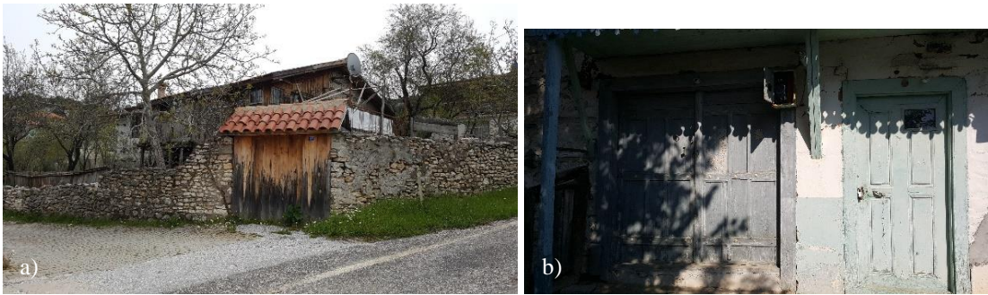
Resim 4.23. Cephedeki uydu çanağının (a) ve elektrik panosunun (b) görüntü kirliliğine yol açması
