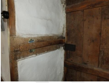
Resim 3.11. Akseki yöresindeki konutların kapılarında bulunan traka/tıfraz sistemi
