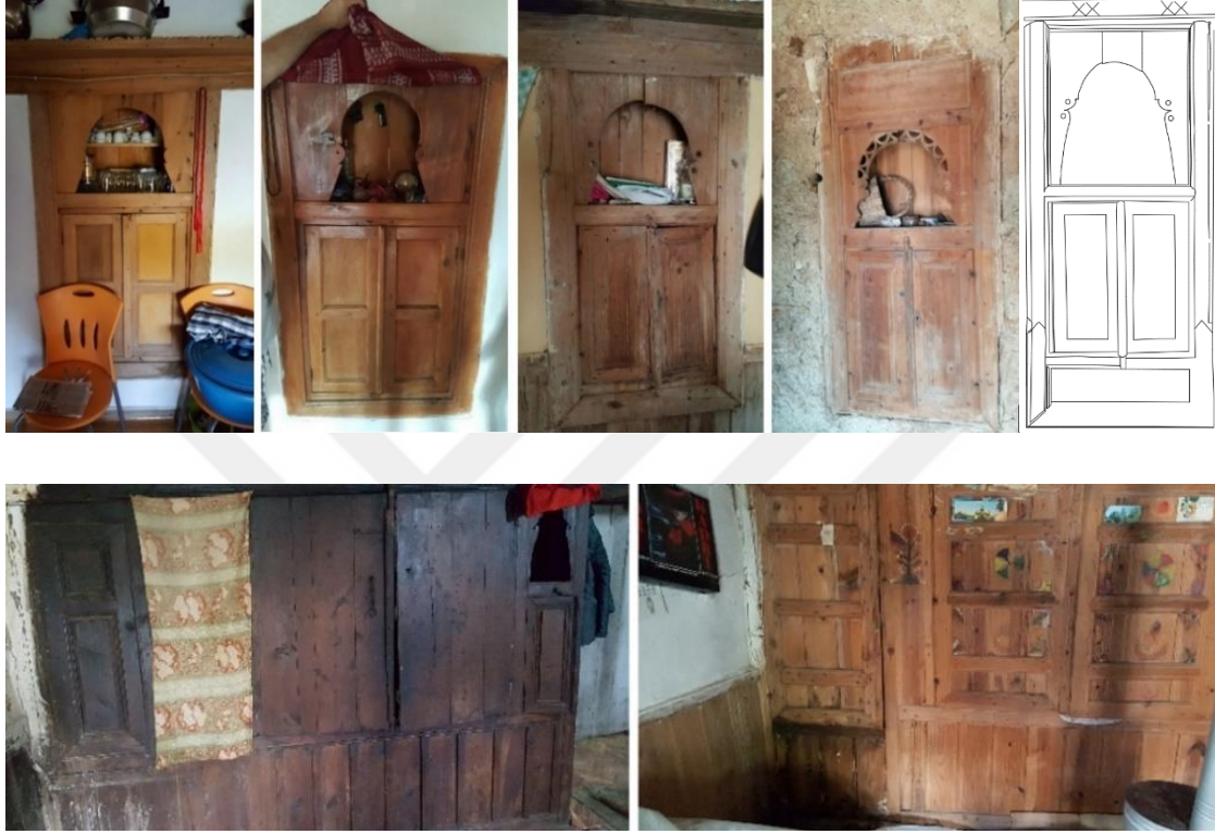
Resim 3.41. Yapılarda bulunan ağız açık, dolap ve yüklükler
