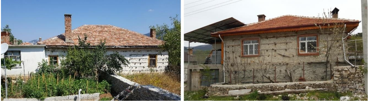
Resim 4.15. Köyde yer alan yapılardaki çatı malzemesi değişimi
