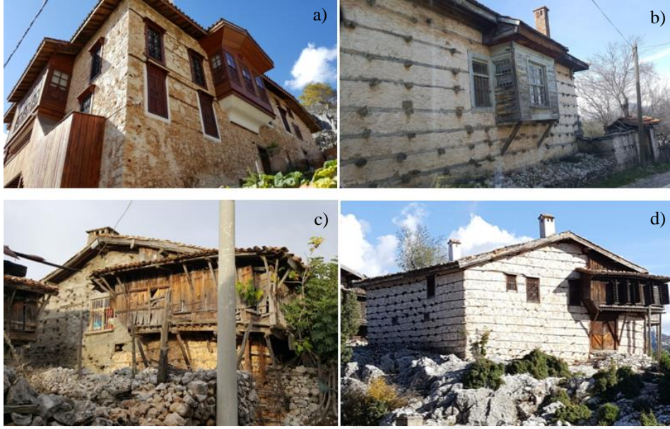
Resim 3.6. Akseki merkez ve Emiraşıklar Köyü'ne ait konutlardaki şahnişinler (a, b) Bucakalan ve Sarıhacılar köylerinde bulunan konutlardaki kafesönü çıkmaları (c, d)
