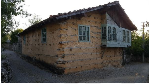
Resim 4.18. Cephede sıva kullanımı
