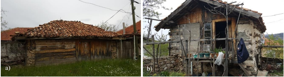
Resim 4.7. Köydeki kırma (a) ve beşik (b) çatılı yapılar
