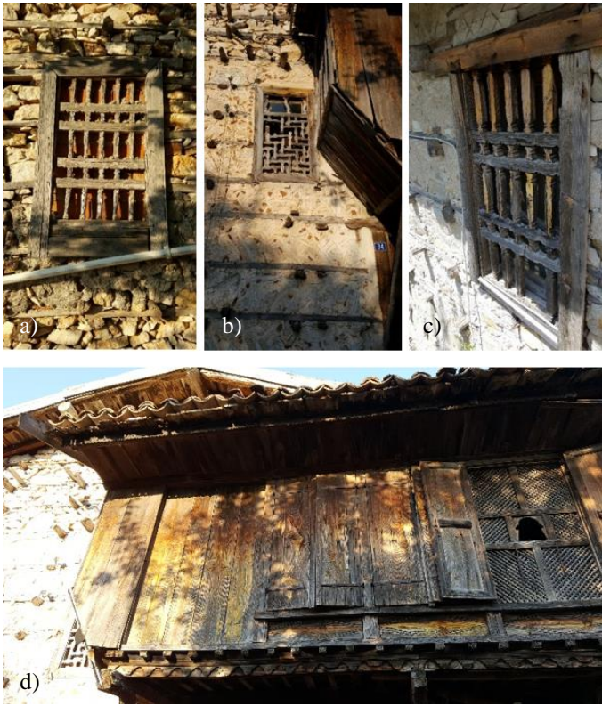
Resim 3.36. Yapılarda bulunan pencereler (a, b, c) ve kafesönü penceresi (d)
