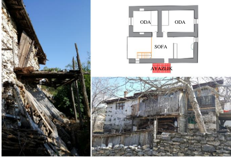
Resim 3.32. Köydeki yapıların ayazlıklarından görünüm
