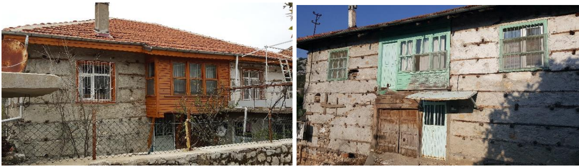
Resim 4.19. Köyde bulunan bir yapıdaki değişime uğrayan şahnişin elemanları
