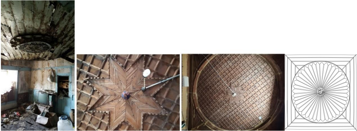
Resim 3.38. Köydeki konutlarda bulunan tavan süslemeleri
