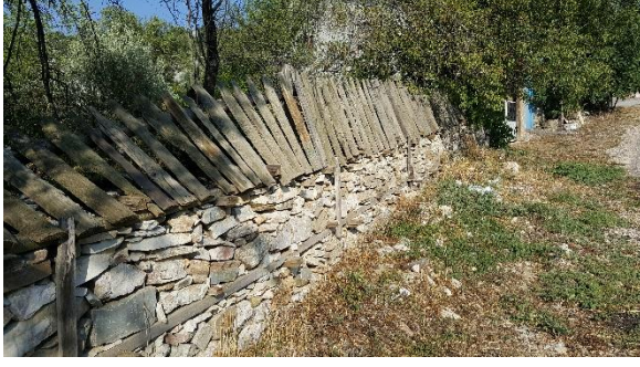
Resim 3.27. Köydeki konut bahçe duvarındaki semerkandi detayı
