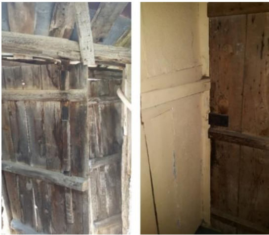
Resim 3.35. Köydeki traka/tıfraz sistemi
