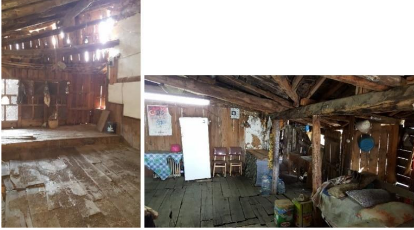
Resim 3.37. Yapıların üst katındaki döşeme
