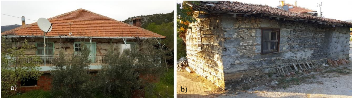
Resim 4.8. Köy bulunan marsilya (a) ve alaturka (b) kiremit kaplamalı çatılar
