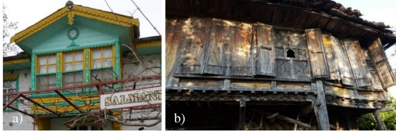
Resim 3.45. Yörede bulunan konutlara ait şahnişin (a) ve kafesönü (b)
