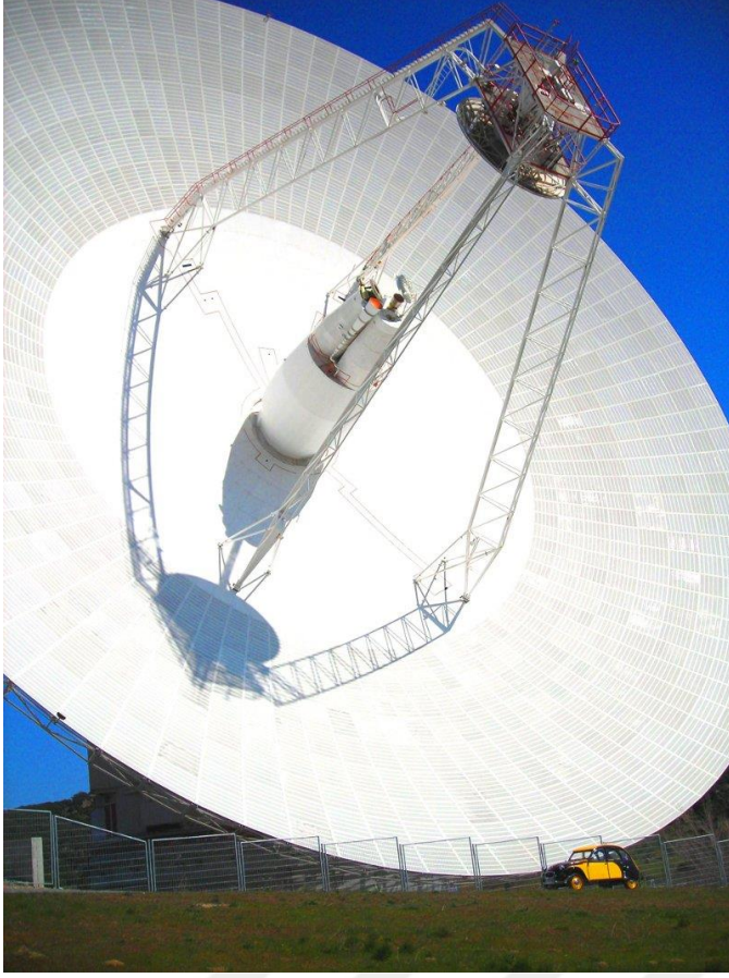
Şekil 2.2. Derin uzay haberleşmesi için kullanılan yansıtıcı anten [6]
