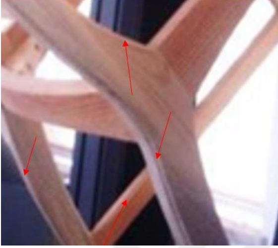
Resim 6.4. Ayak ve kayıt elemanlarının yüzey kenarlarına açılmış iç kavis profili
