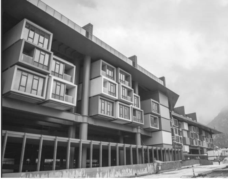
Şekil 6.6. Müze Otel'in ön cephesinden konteynır biçimli modüler yatak ünitelerinin görünüşü (EAA, 2014)
