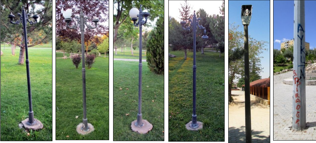
Şekil 4.63. Vandalizm eylemine maruz kalan aydınlatma elemanları
