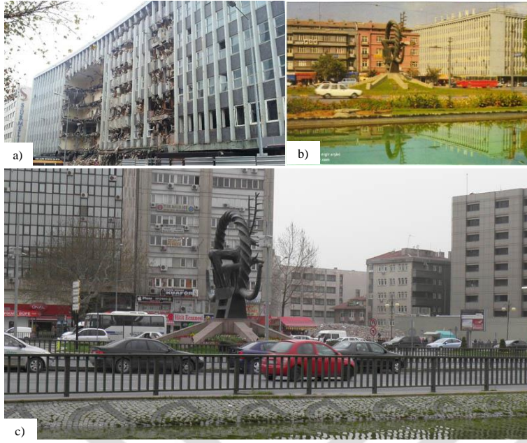
Resim 4.4. (a) Etibank'ın yıkım anının görüntüsü, (İnternet: URL-66) (b) Etibank'ın Cumhuriyet'in ilk yıllarındaki görünüşü, (c) Etibank'ın yıkımından sonraki fotoğraf, (İnternet: URL-67)
