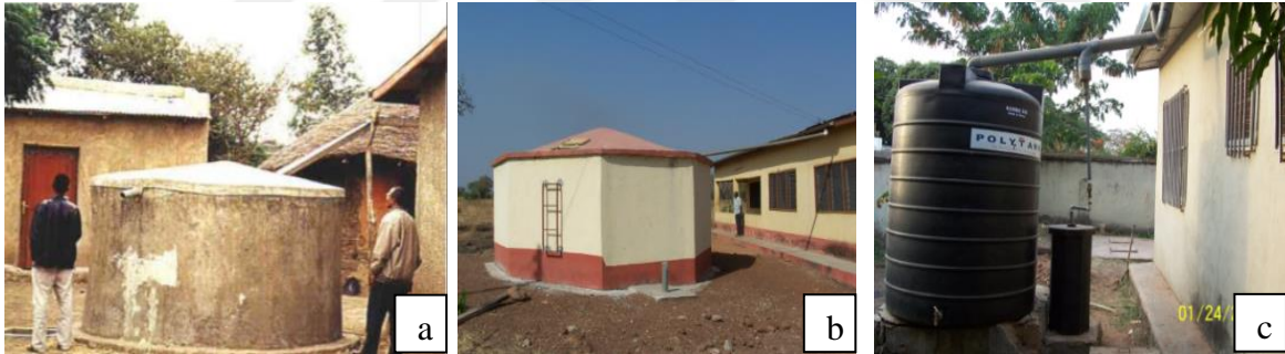
Şekil 2.15. (a) Etiyopya'da uygulanan çatı suyu toplama, (b ve c) Gana'da uygulanan çatı suyu toplama (Barnes, 2009)
