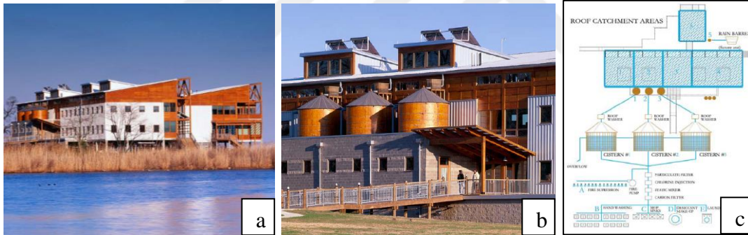
Şekil 2.22. (a ve b) Philip Merrill genel görünümü, (c) yağmur suyu toplama sistemi (URL-14).
