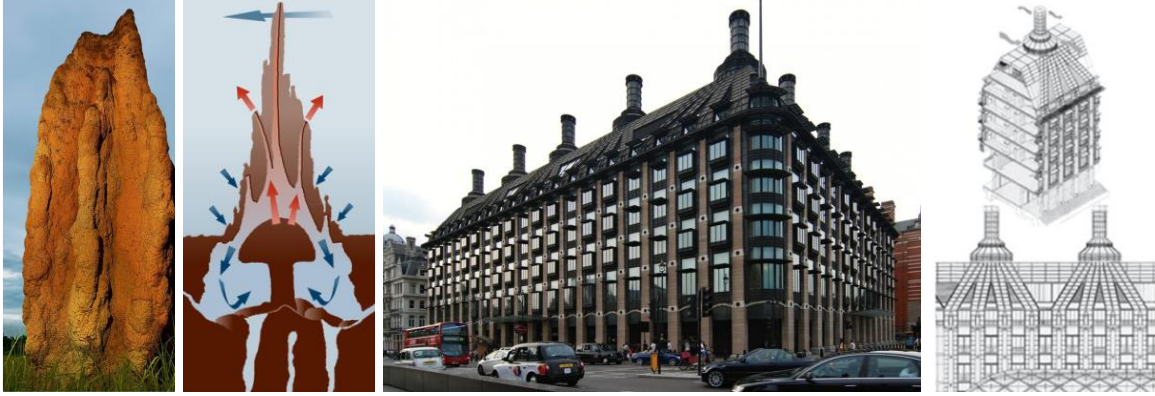
Şekil 2.6. Termit höyüğünün iklimlendirme prensiplerinden esinlenerek tasarlanan Portcullis House Binası ve havalandırma sisteminin şematik gösterimi (URL-2)
