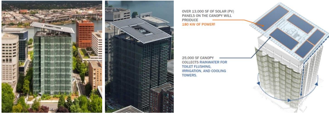
Şekil 2.26. Wendell Wyatt Federal Building genel görünümü ve yağmur suyu toplama sisteminin şematik gösterimi (URL-17).
