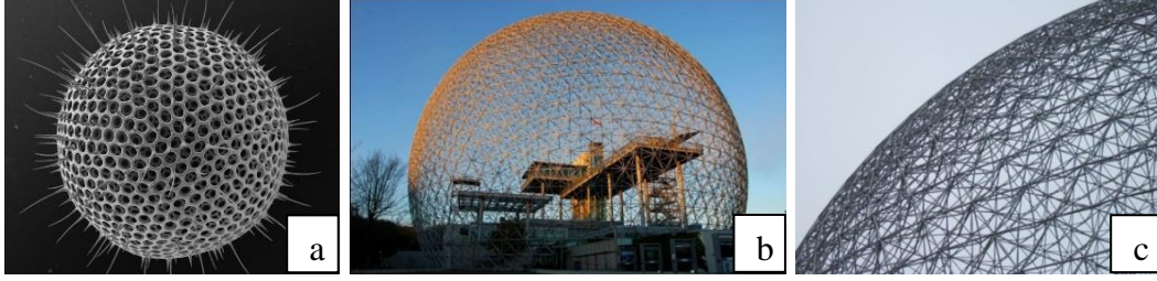
Şekil 2.13. (a) Radiolarianın mikroskopik görüntüsü (URL-7), (b ve c) Fuller'in Radiolarianın iskelet yapısından esinlenerek tasarladığı jeodezik kubbe (URL-8)
