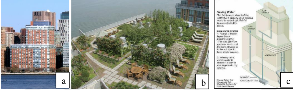
Şekil 2.25. (a) The Solaire genel görünümü, (b) The Solaire'in yeşil çatısı, (c) yağmur suyu toplama sistemi (URL-16).
