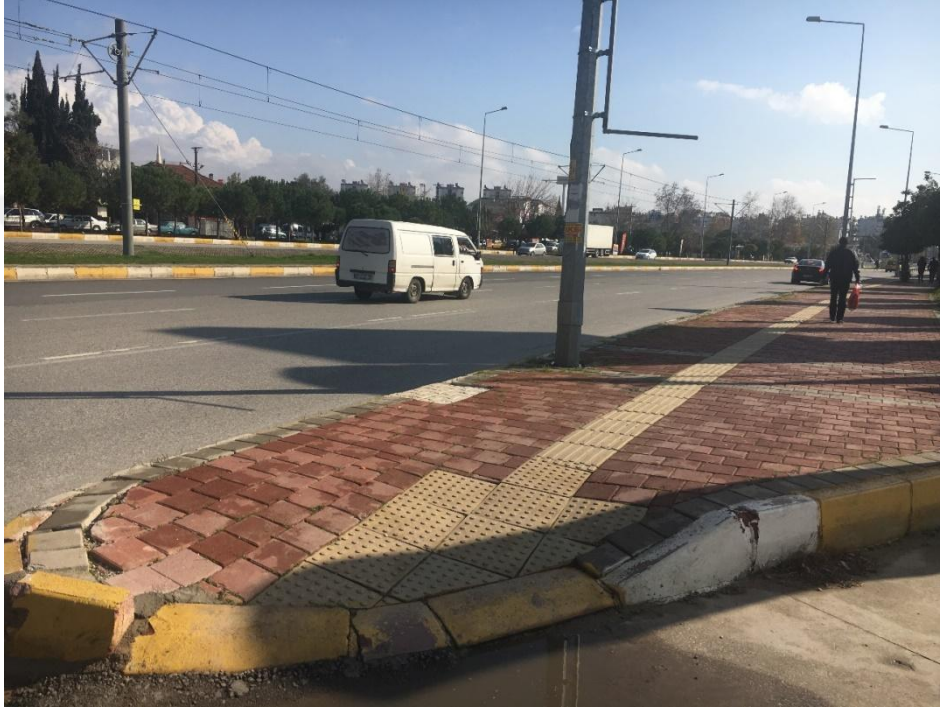
Şekil 4.38. Namık Kemal Bulvarı rampa ve görme engelli rehber yolu
