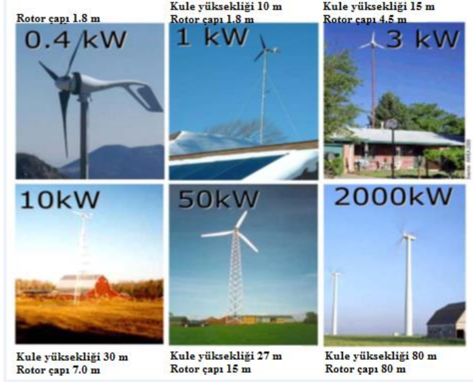
Resim 1.2. Yatay eksen türbinlerine örnekler (Richards ve diğerleri, 2011)
