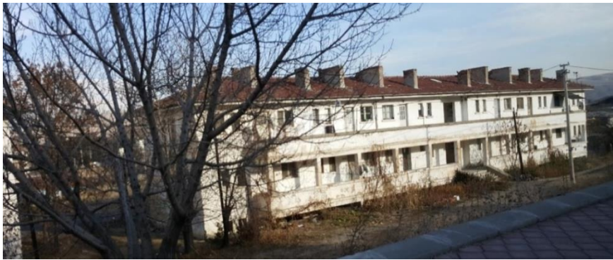
Resim 6.40. 7 numaralı lojman binası arka cephe
