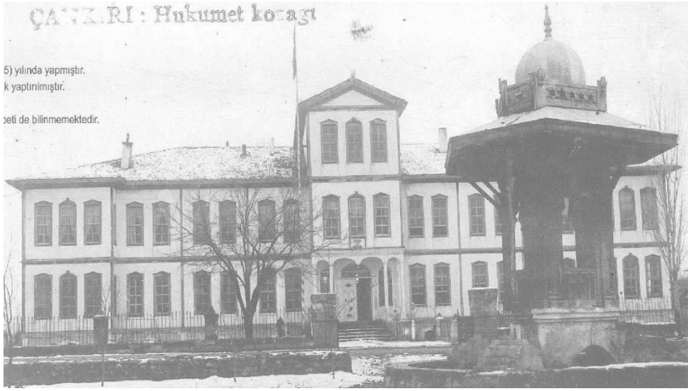
Resim 6.4. Hükûmet Konağı Binası (Demiröz, 2001: 28)
