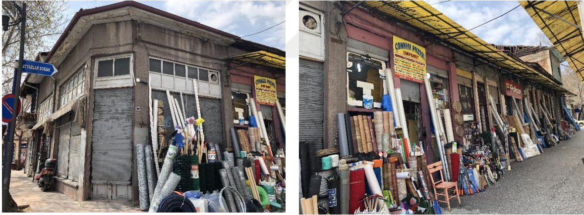
Resim 5.3. Attarlar Sokakta bulunan dükkanların günümüzdeki durumu
