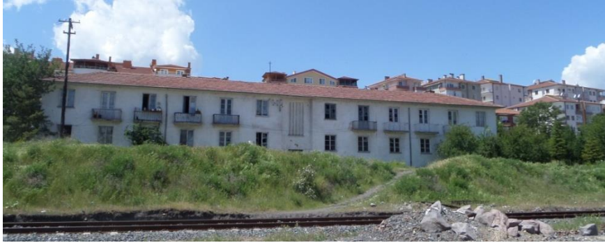
Resim 6.39. 6 numaralı lojman binası ön cephe
