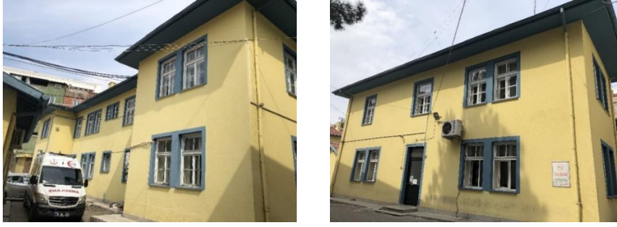
Resim 6.52. Verem Savaş Dispanseri Binası Arka ve Yan Cepheler
