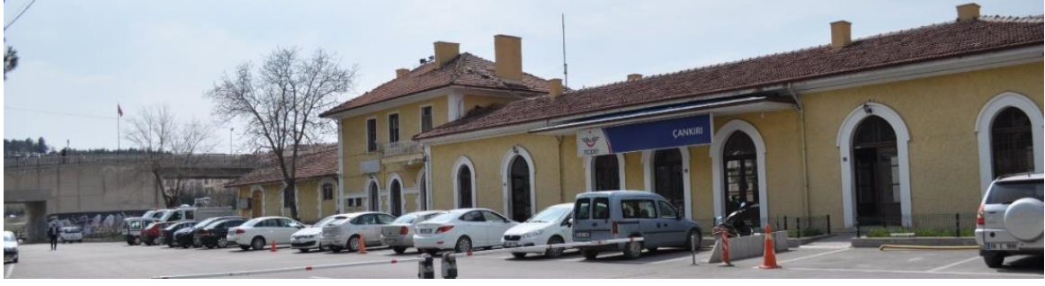
Resim 6.27. İstasyon Binası Arka Cephe
