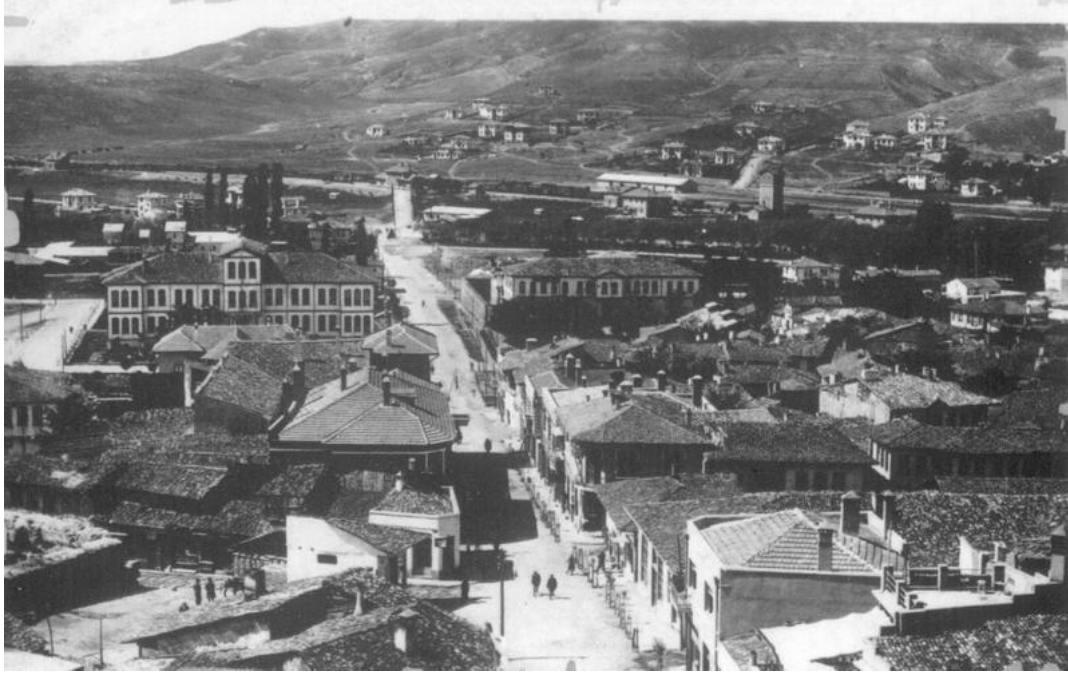
Resim 3.4. 1932 tarihli fotoğrafta solda görülen yapı Hükûmet Konağı, sağdaki yapı ise Cezaevi binasıdır (Demiröz, 2001: 36)
