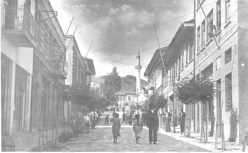
Resim 3.5. Caddenin sonunda Sultan Süleyman Cami minaresinin yanında görülen yapı, Kız İnas Mektebi'dir (Demiröz, 2001: 29)
