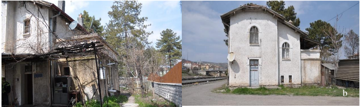
Resim 6.37. a) 4 Numaralı Lojman Binası, b) Giriş cephesi
