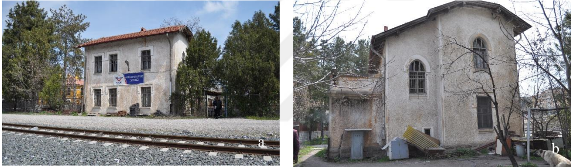
Resim 6.36. a) Günümüzde idarî bina olarak kullanılan 3 Numaralı Lojman Binası, b) Yan Cephe
