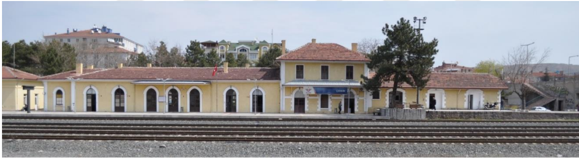
Resim 6.25. İstasyon Binası Ön Cephe
