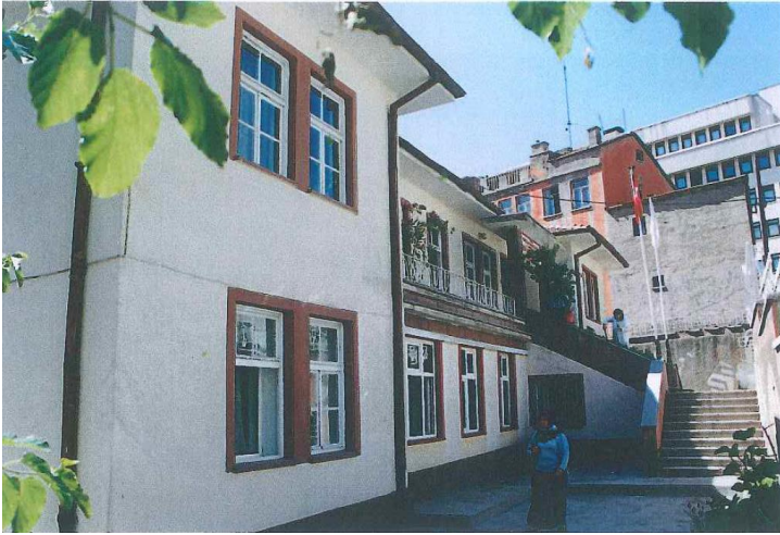
Resim 6.50. Yapının 2001 yılındaki durumu - Koruma Bölge Kurulu Arşivi
