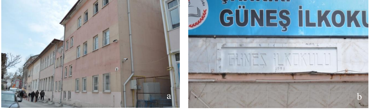
Resim 6.55. a) Güneş İlkokulu Arka Cephe, b) Ön Cephe Detay
