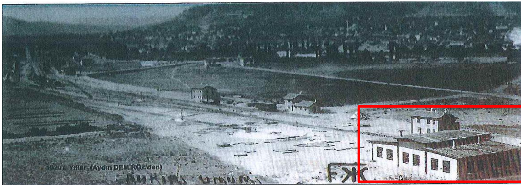
Resim 6.32. Kırmızı çerçeveli yapı cer atölyesidir (Demiröz, 2001: 24)
