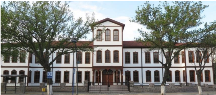
Resim 6.5. Hükümet Konağı Ön Cephe
