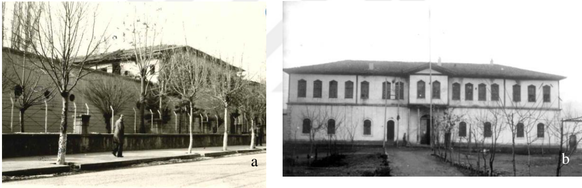
Resim 6.12. a) 1985 Tarihli Cezaevi Binası Yan Cephe - Koruma Bölge Kurulu Arşivi, b) Cezaevi Binası - Çankırı İl Kültür Turizm Müdürlüğü Arşivi
