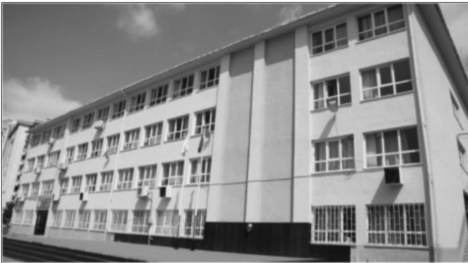
Resim 6.1. MEB tip okul binası dış görünüşü
