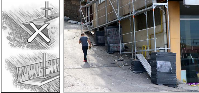
Resim 5.5. Taban plakasının bastığı zeminin düz olmadığını gösteren yanlış uygulama örnekleri
