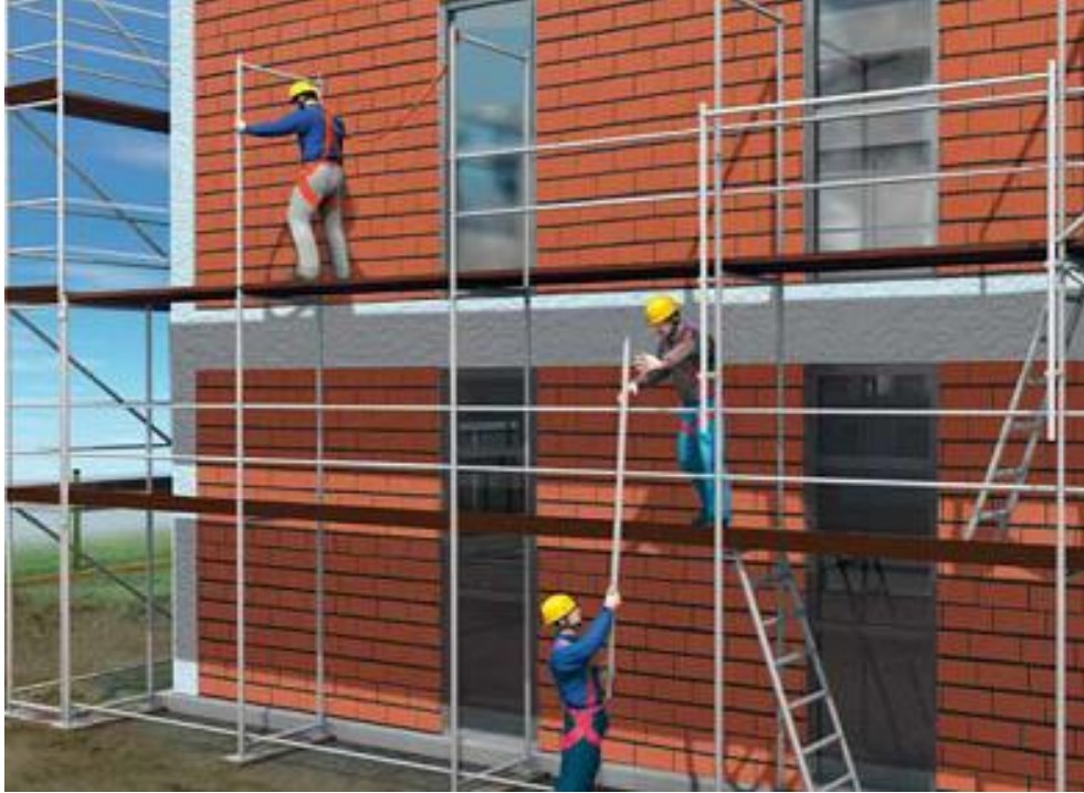
Resim 5.12. İskele üzerinde kullanılması gerekli kişisel koruyucu donanım (paraşüt tipi emniyet kemeri)
