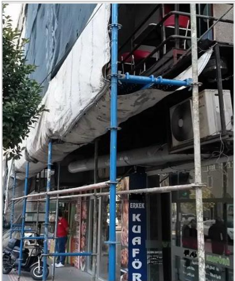
Resim 5.10. Kaplanmış dış cephe iskelesi
