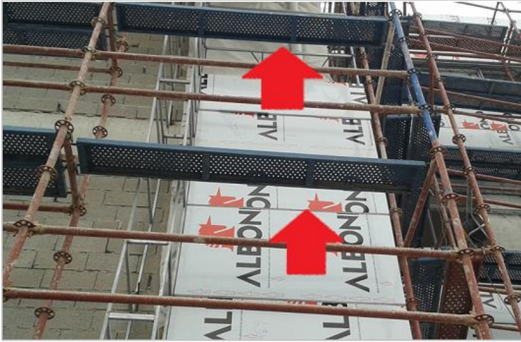
Resim 5.6. Mimari açıdan alüminyum konstrüksiyon nedeniyle yapı ile iskele arası boşluk
