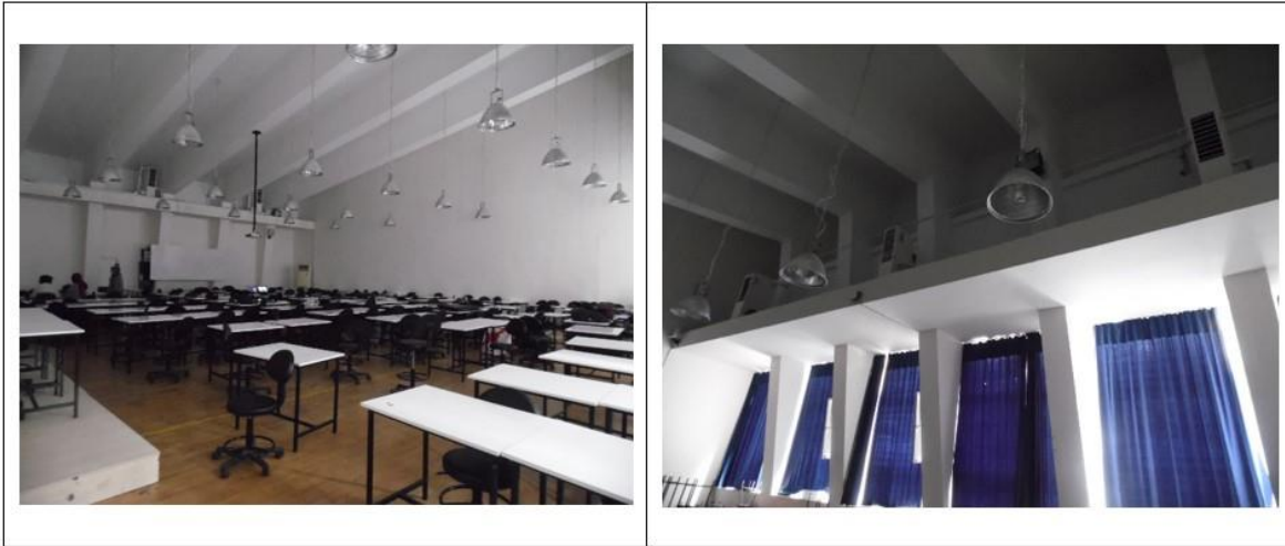
Resim 3.23. Spor salonundan dönüştürülen stüdyonun aydınlatma sistemleri
