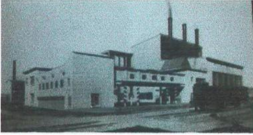
Resim 3.29. Elektrik santrali 1938 (Asiliskender, 2002)
