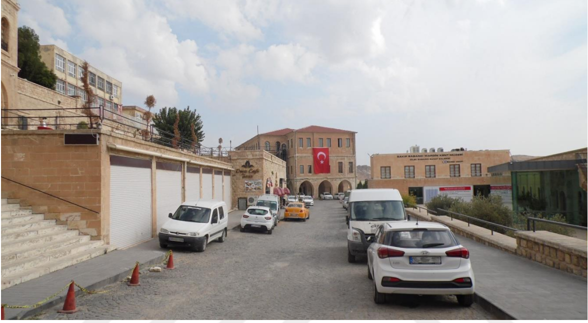
Resim 3.66. Cumhuriyet Caddesi'nden binanın batı cephesinin görünümü
