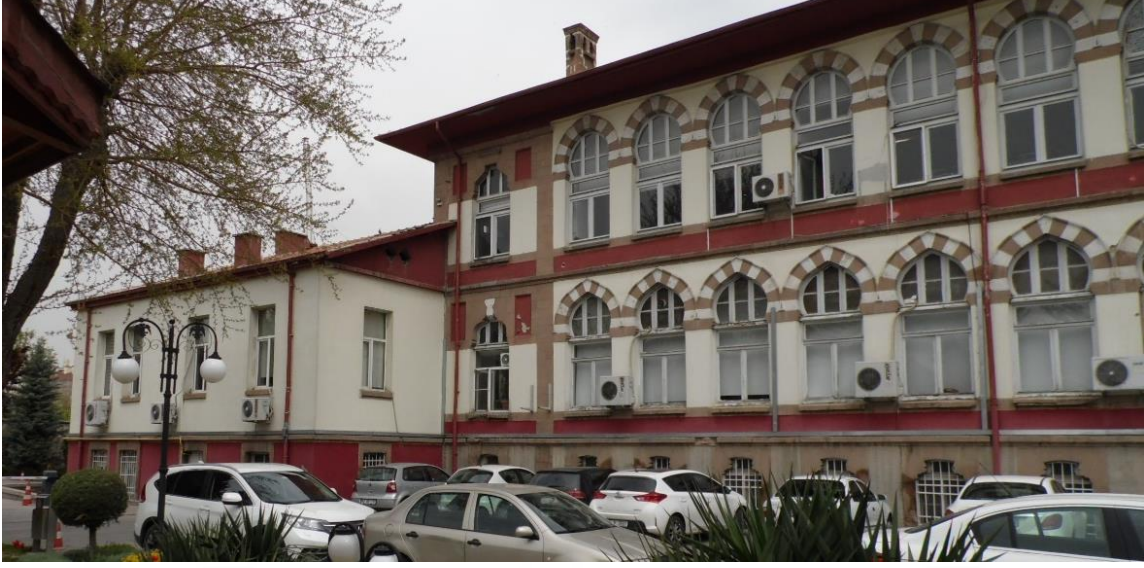
Resim 3.24. Isıtma ve soğutma sistemlerinin cepheye etkisi
