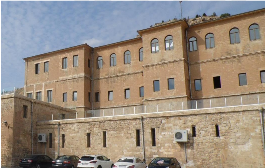
Resim 3.80. Bodrum kat cephesinde yer alan klima soğutucuları
