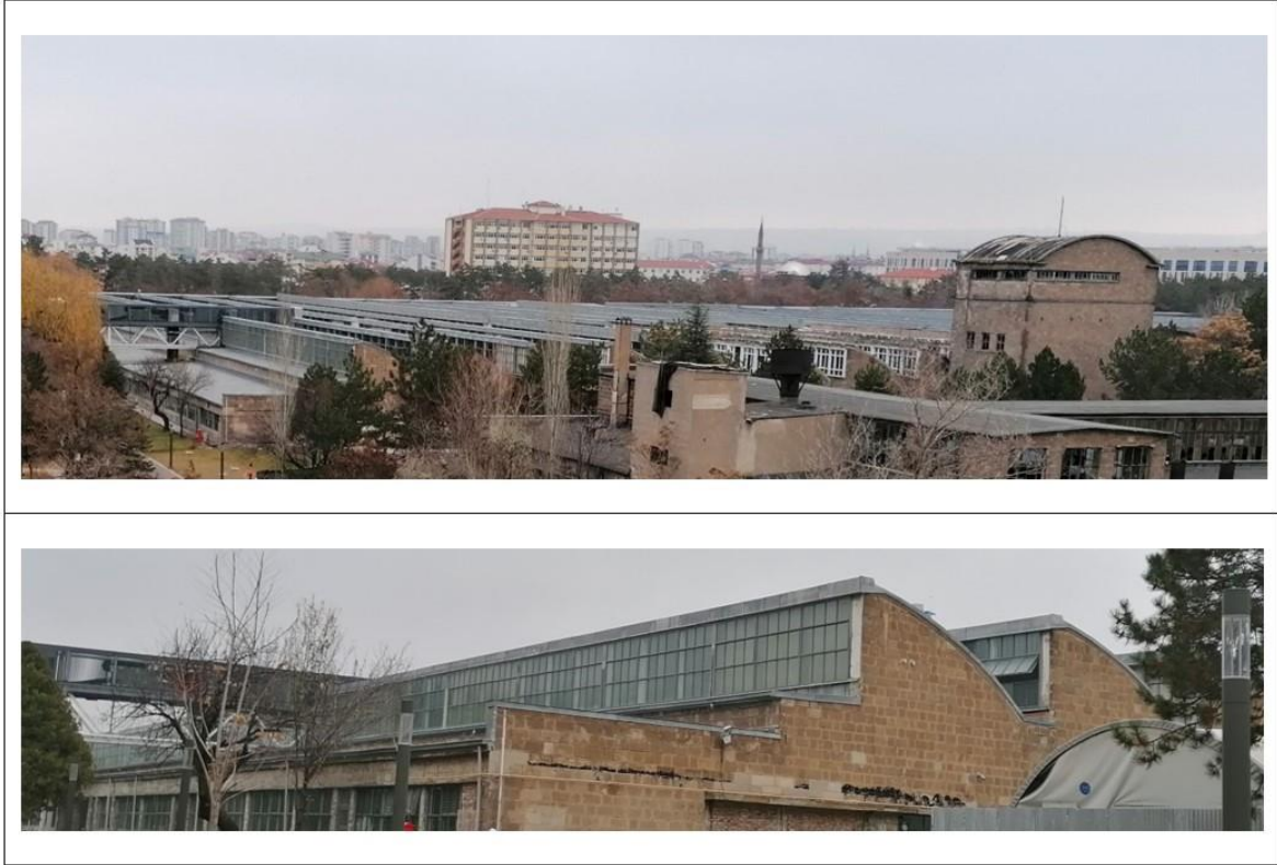
Resim 3.28. Araştırma geliştirme ve tasarım merkezi olarak işlevlendirilen üretim binası
