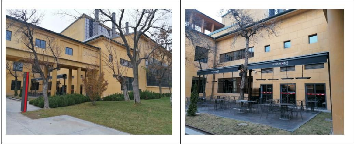
Resim 3.31. Elektrik santrali binasının girişı ve avlusu
