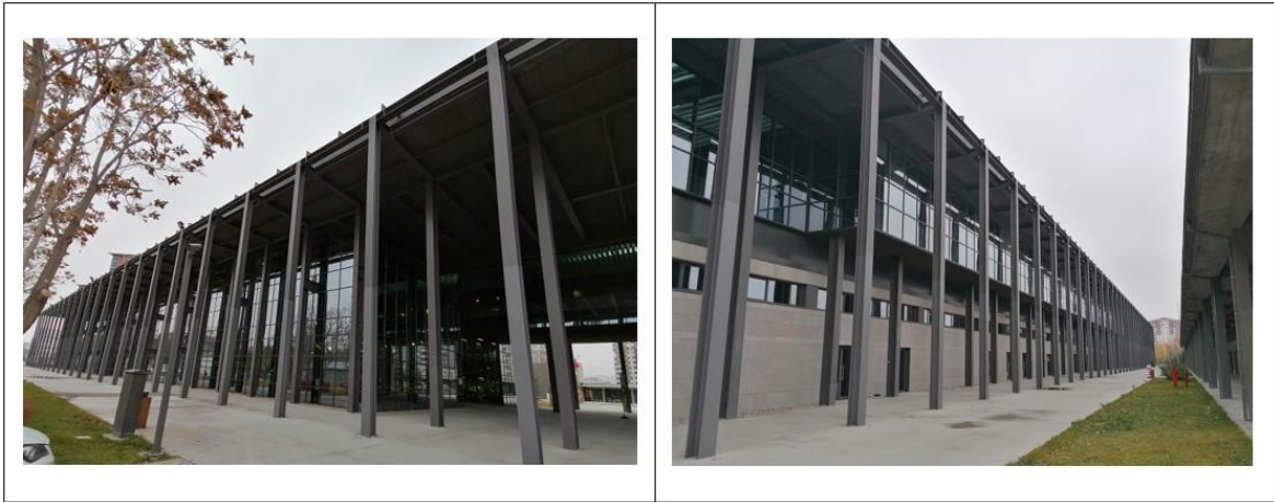
Resim 3.55. Eski depo ve yeni ek binanın kuzeydoğu cephesi
