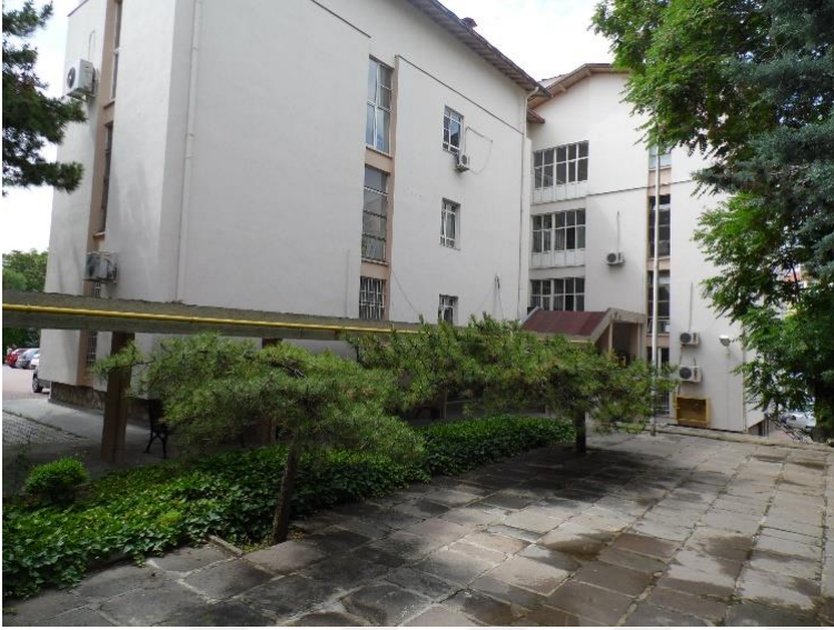
Resim 3.7. Konya Teknik Üniversitesi Mimarlık Fakültesi ek bina genel görünümü
