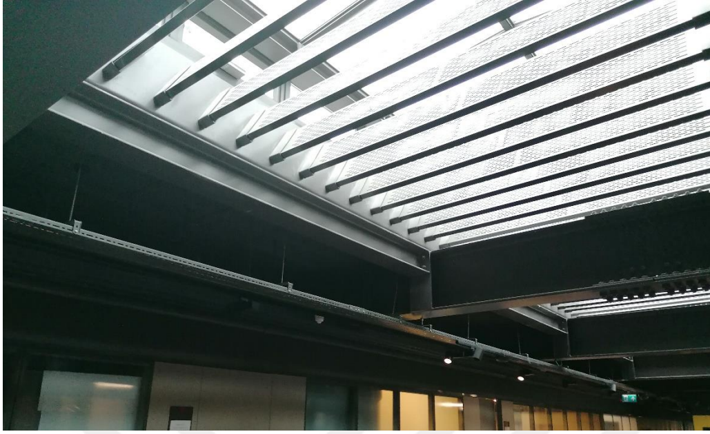
Resim 3.60. Tavan pencereleri ve güneş kırıcılar
