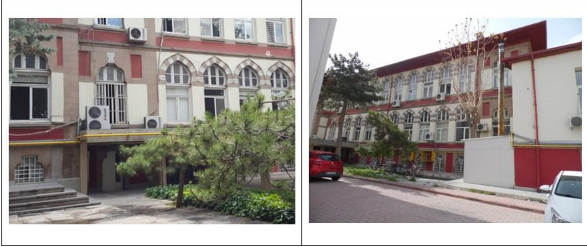
Resim 3.20. Kuzey cephesine ait görseller
