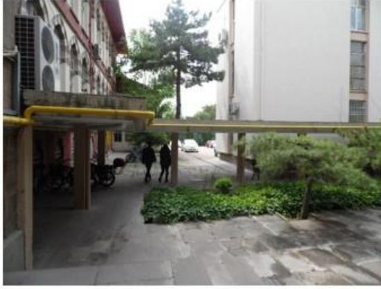
Eski bina ile ek binanın bağlantısı
