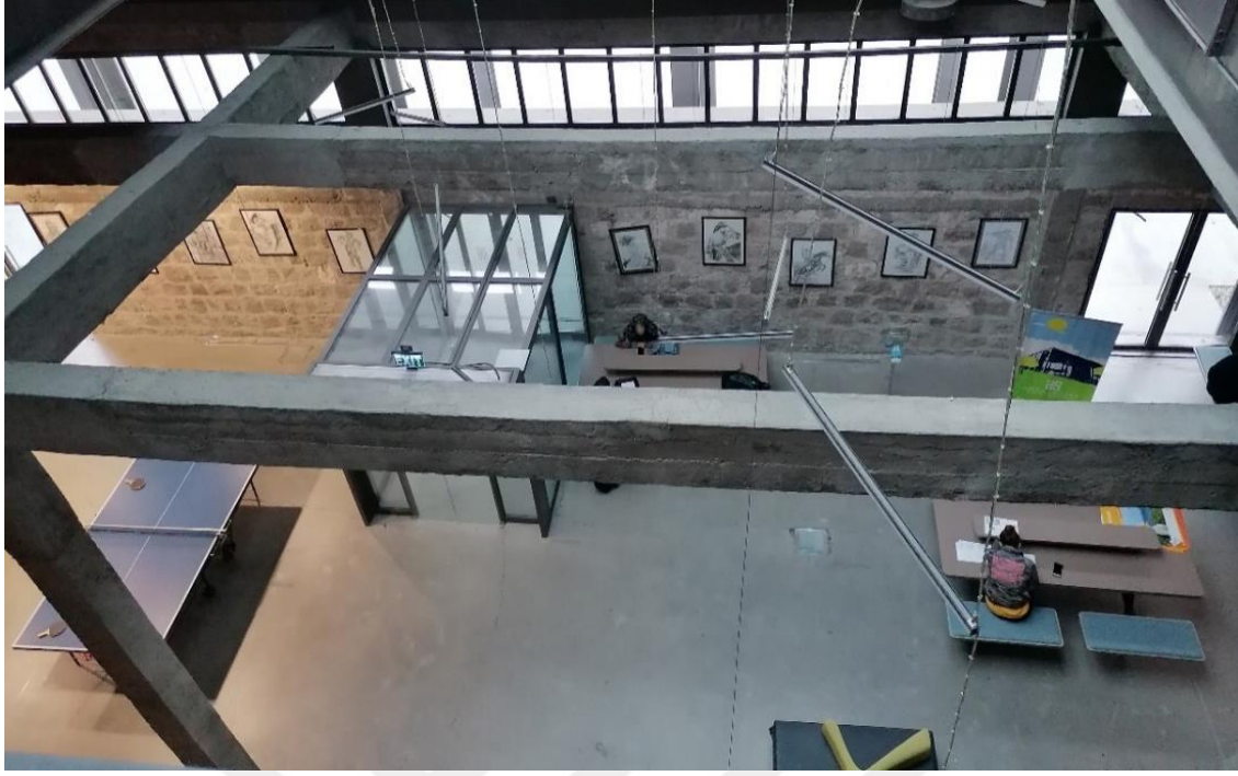
Resim 3.50. Depo binasının özgün taşıyıcı sistemi ve duvarları
