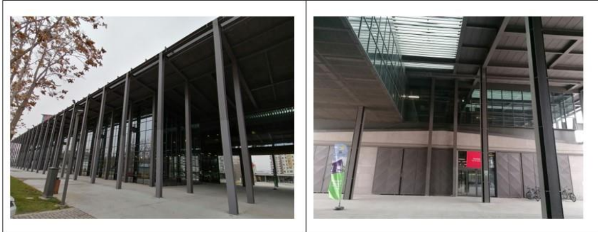
Resim 3.34. Eski bina ile ek binanın birleşimi ve bütünlüğü
