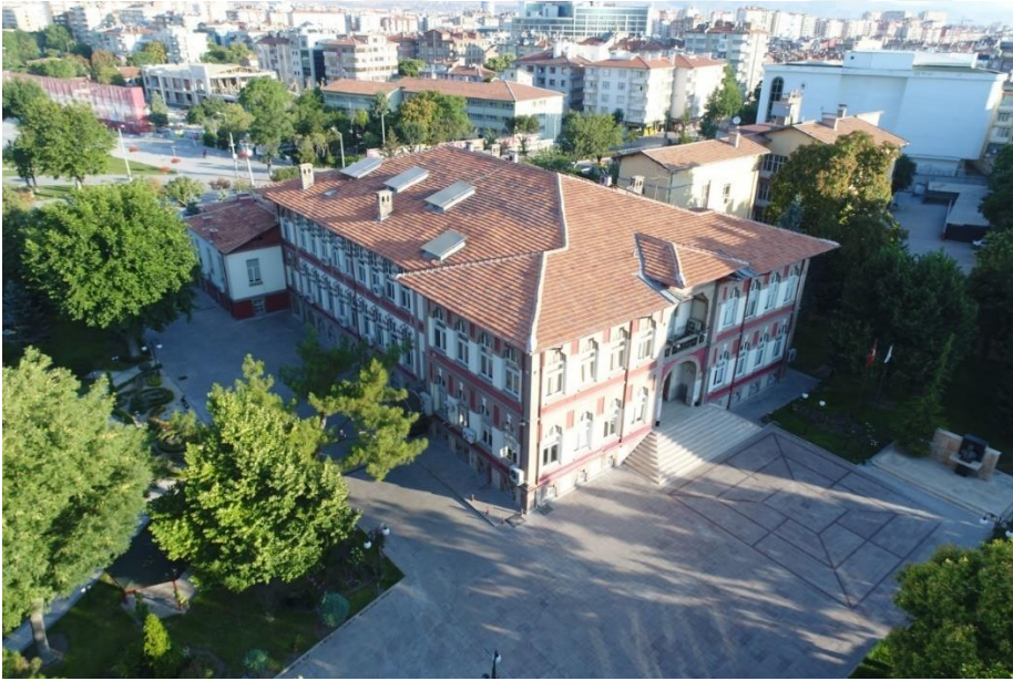
Resim 3.3. Konya Teknik Üniversitesi Mimarlık Fakültesi Binası genel görünümü (URL-10)
