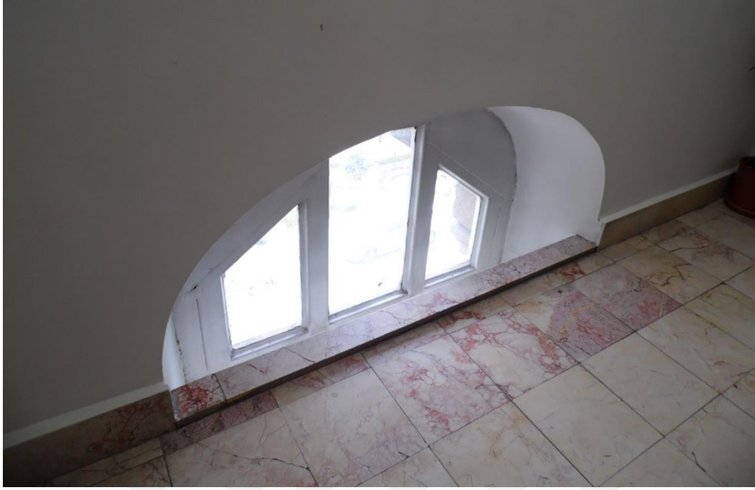
Resim 3.18. Merdiven ile pencerenin kesişim detayı
