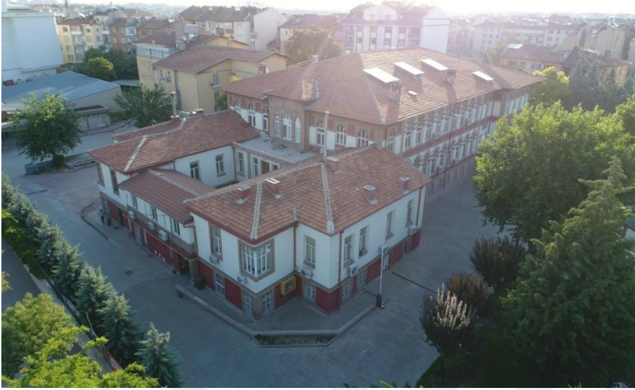
Resim 3.2. Konya Teknik Üniversitesi Mimarlık Fakültesi Binası genel görünümü (URL-9)
