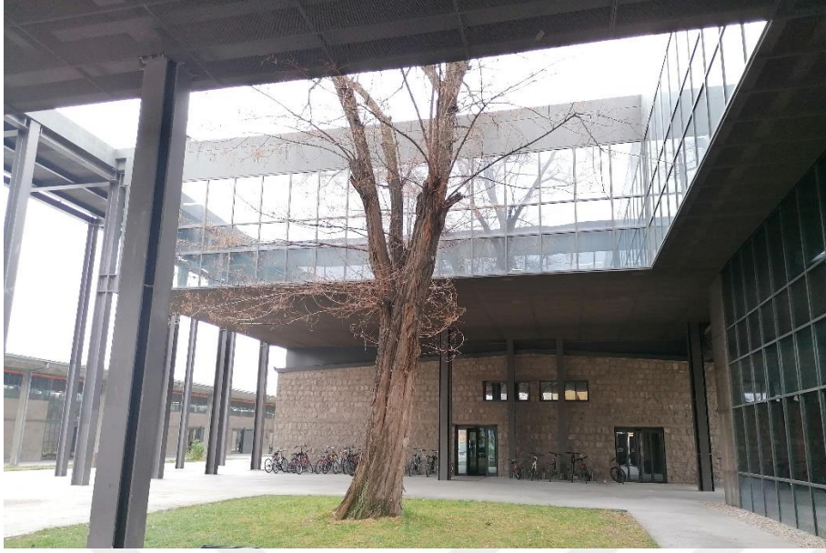
Resim 3.56. İdare ve derslik binası avlu ve girişi
