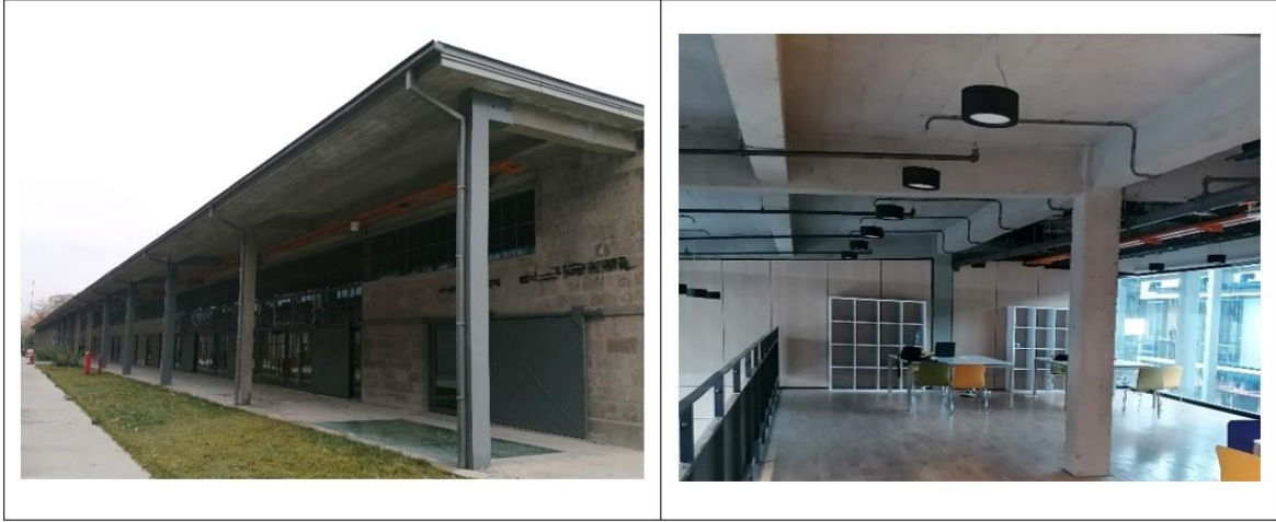
Resim 3.53. Eğitim binası olarak işlevlendirilen ambarın taşıyıcı sistemi
