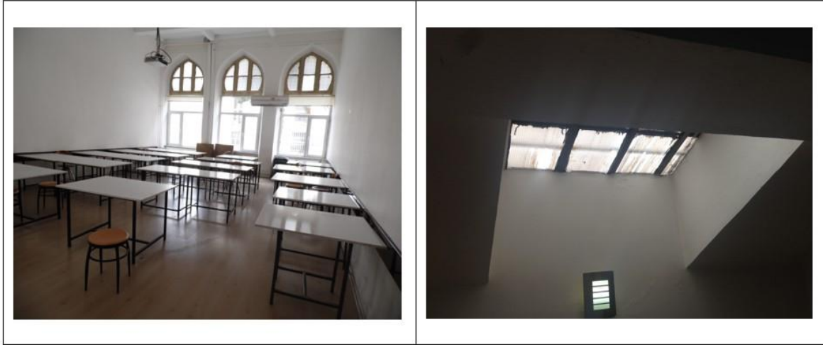
Resim 3.22. Cephede ve çatıda yer alan doğal aydınlatma elemanları
