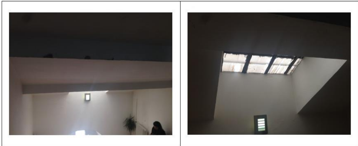
Resim 3.17. Çatı katı taşıyıcıları ve tavan penceresi
