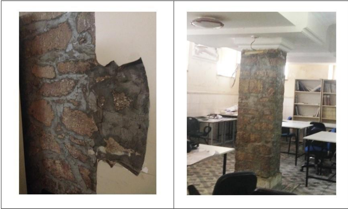
Resim 3.15. Yapı taş duvar ve kolon detayı
