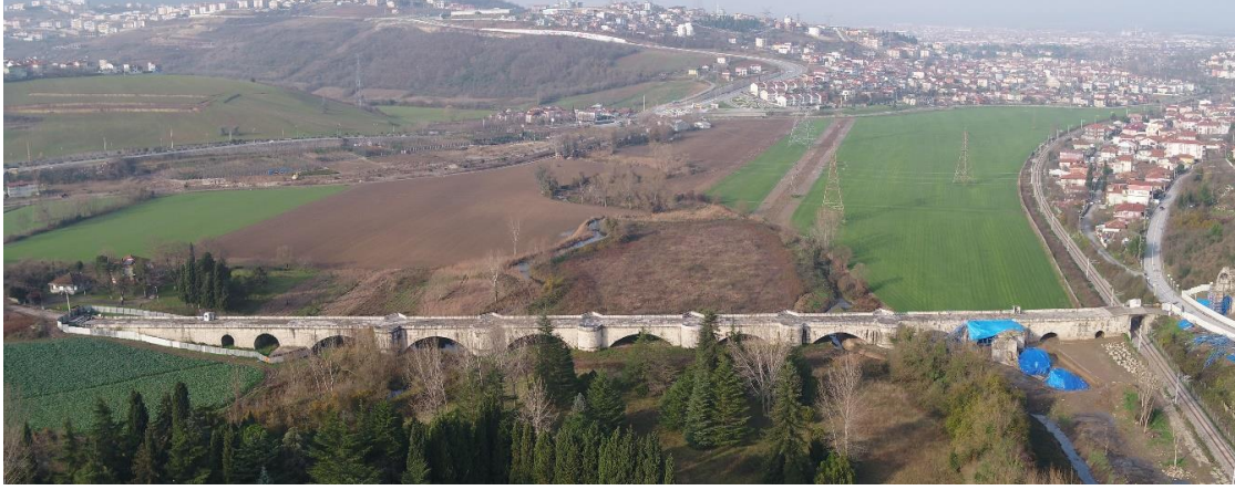
Resim 4.112. Sangarios Köprüsü genel görünüm
