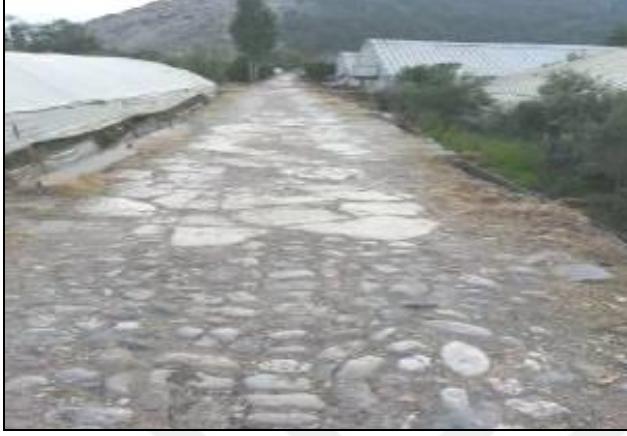
Resim 4.107. Alakır Köprüsü döşemesi
