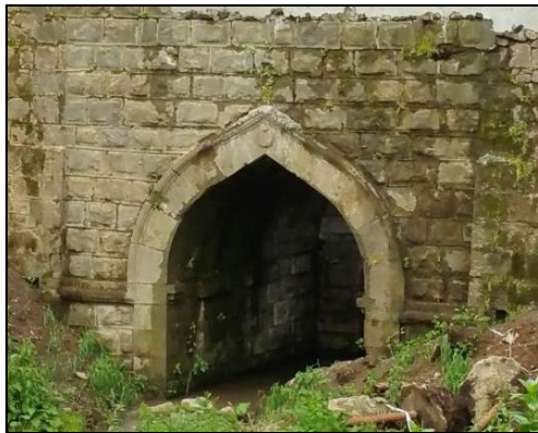
Resim 4.52. Çilekli Köyü Köprüsü /Trabzon / iki merkezli teğet kemer
