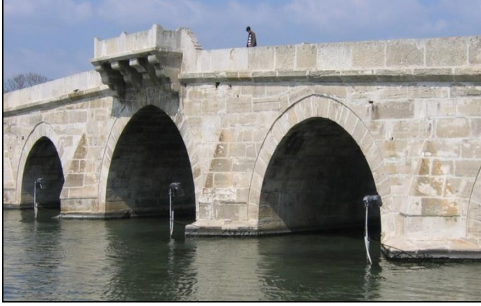
Resim 4.78. Büyükçekmece Köprüsü / İstanbul / Osmanlı
