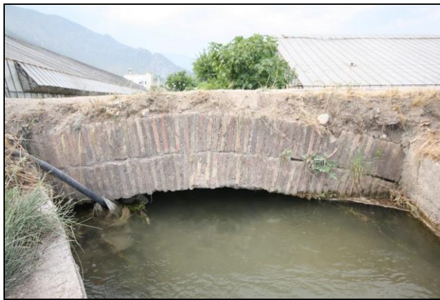
Resim 4.103. Alakır Köprüsü ve kemer içinden geçen beton kanal
