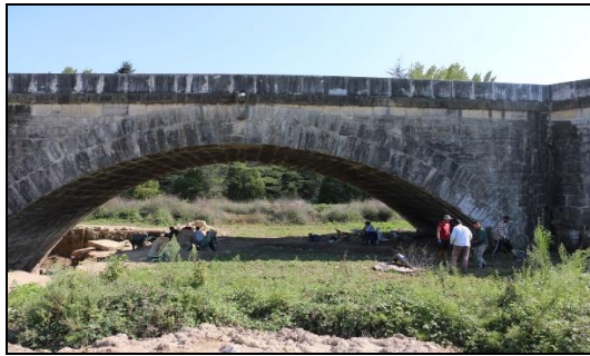
Resim 4.111. Sangarios Köprüsü ana kemer ve yan kemerleri
