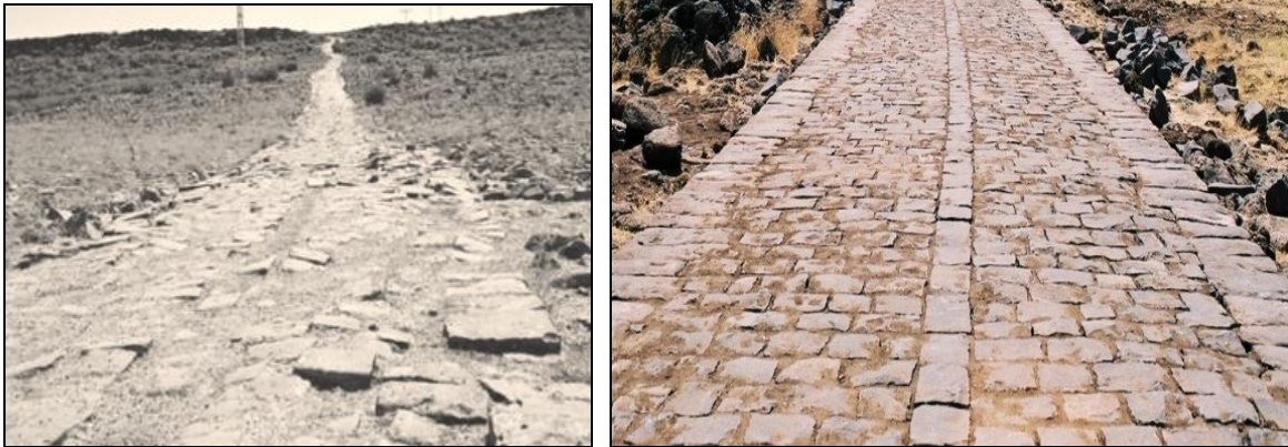
Resim 4.9. Diyarbakır İli ve Eğil İlçesi arasında bulunan 1951 m. uzunluğundaki Roma Dönemi Yolu, restorasyon öncesi ve sonrası durumu (KGM, 2018)
