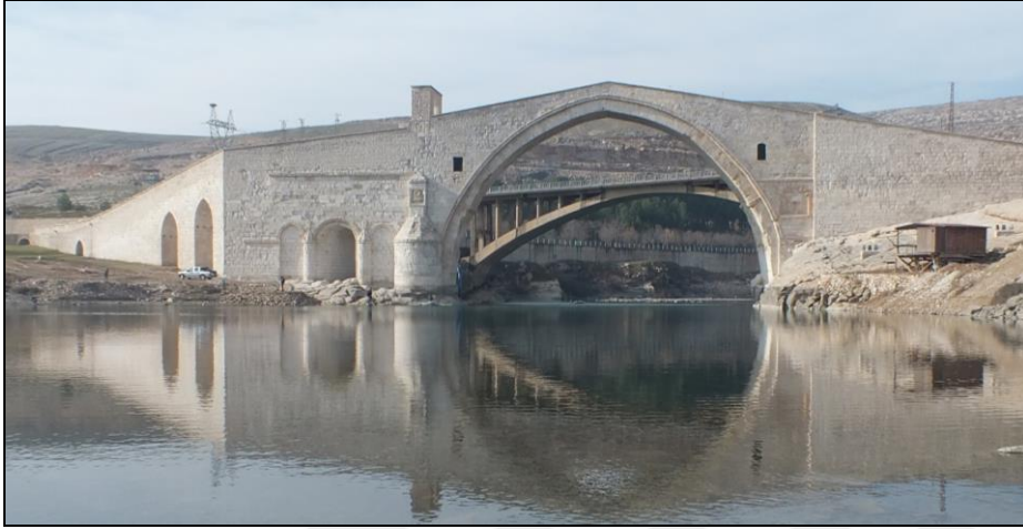
Resim 4.116. Malabadi Köprüsü günümüzdeki görünümü (KGM, 2018)
