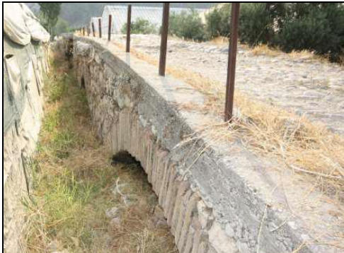
Resim 4.108. Alakır Köprüsünün yan görünüşü
