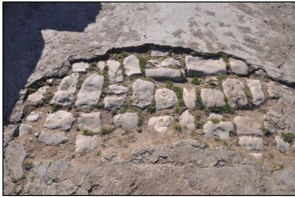
Resim 4.118. Malabadi Köprüsü araştırma kazısında ortaya çıkan döşeme
