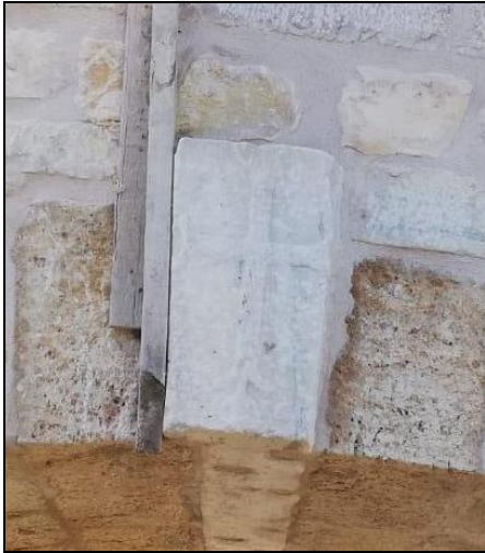
Resim 4.89. Kastamonu İli, Taşköprü kilit taşında bulunan haç kabartması
