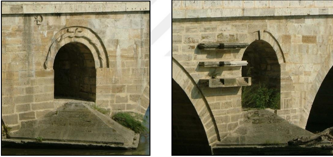
Resim 4.84. Edirne İlinde bulunan Osmanlı Dönemi eseri Meriç Köprüsü’nün kemerindeki ejder motifi ve suluk
