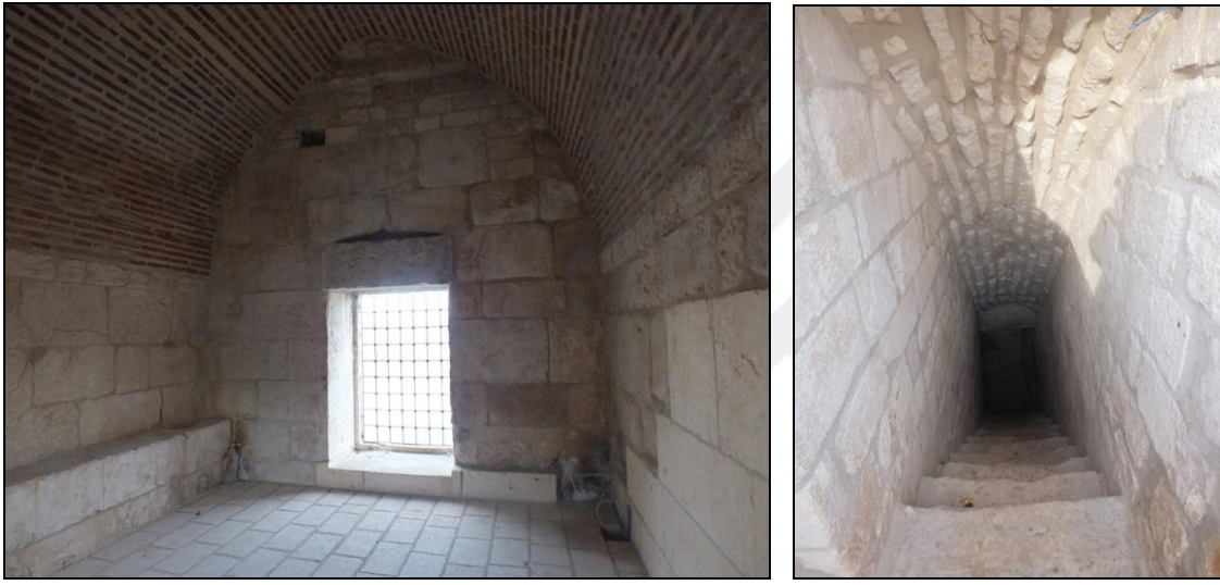
Resim 4.122. Malabadi Köprüsü odacıklar
