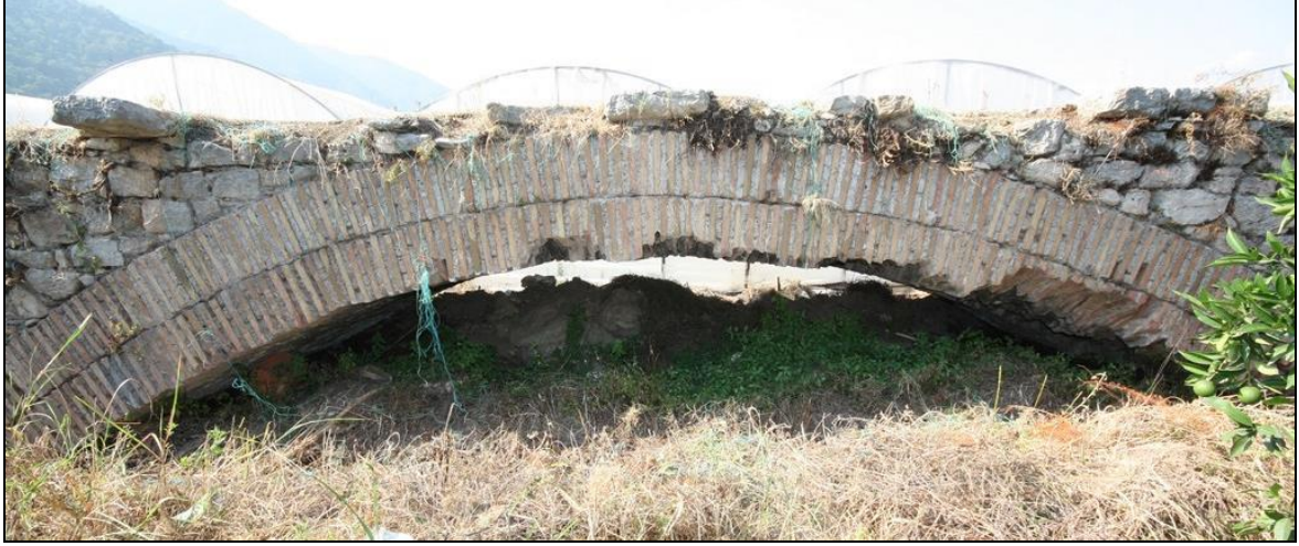
Resim 4.105. Alakır Köprüsü kemeri
