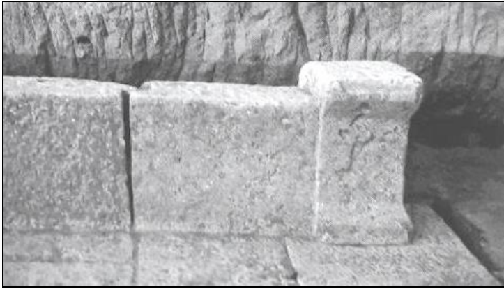
Resim 4.65. Çanakkale İlinde bulunan ve Roma Dönemi eseri olan Gülpınar Köprüsü korkuluk ve baba taşı (Özgünel, 2005)
