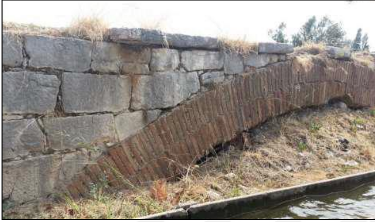
Resim 4.109. Alakır Köprüsü korniş taşları
