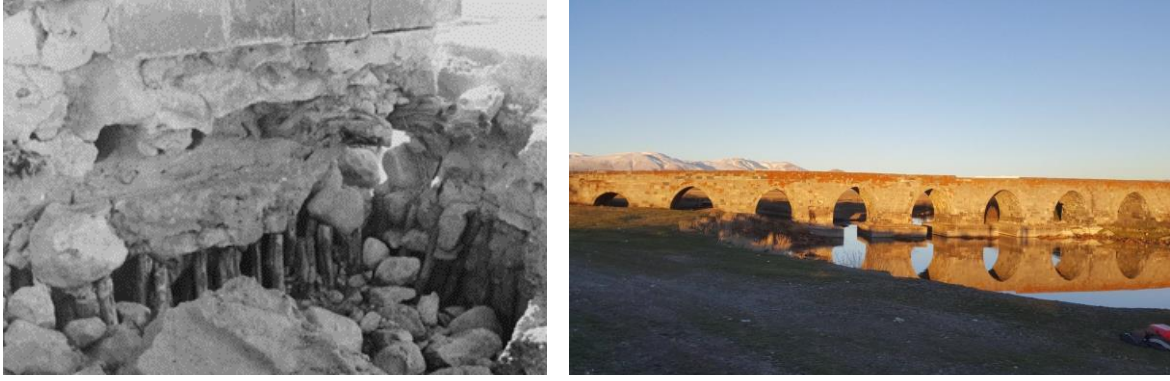
Resim 4.99. Karaz Köprüsü / Erzurum / Osmanlı Dönemi (KGM, 2018)
