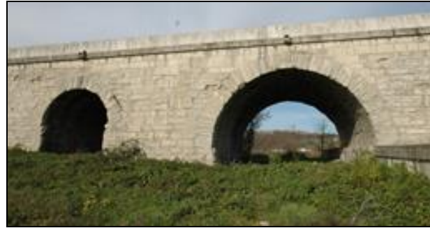
Resim 4.111. Sangarios Köprüsü ana kemer ve yan kemerleri
