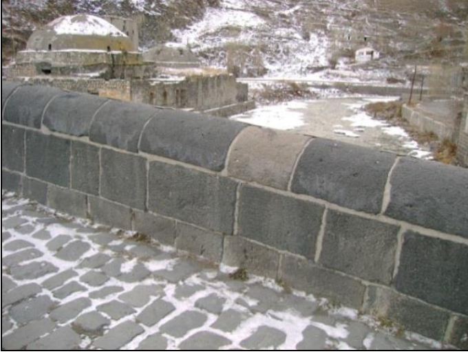
Resim 4.72. Taş Köprüsü/ Kars / Osmanlı Dönemi
