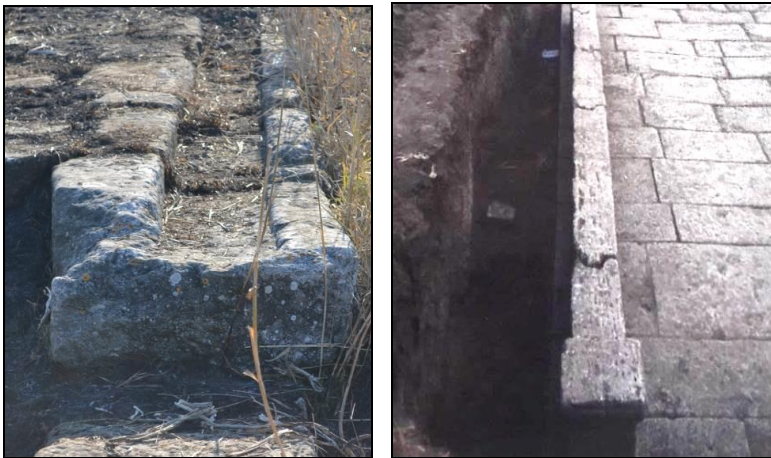
Resim 4.66. Gülpınar Köprüsü korkuluk ve korniş taşları (Özgünel, 2005)
