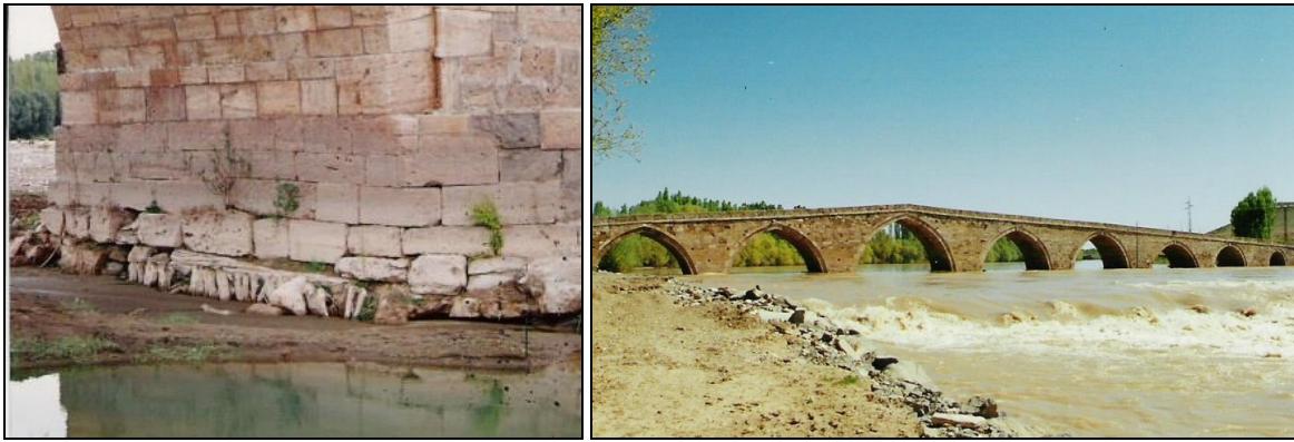
Resim 4.98. Şahruh Köprüsü / Kayseri / Selçuklu Dönemi
