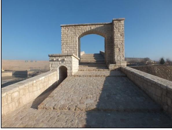
Resim 4.119. Malabadi Köprüsü restorasyon sonrası döşeme
