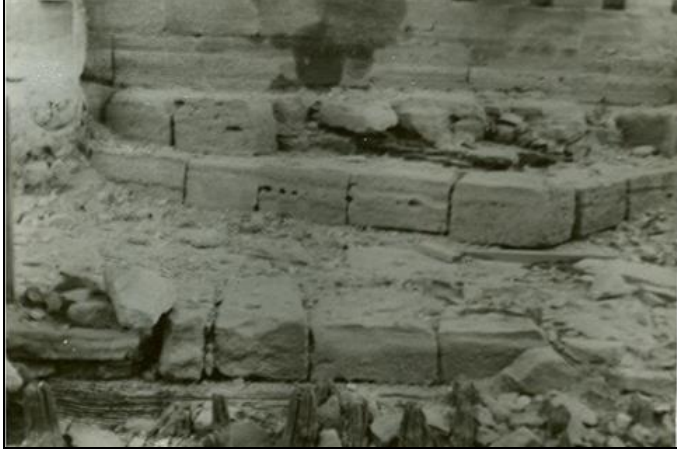
Resim 4.126. Uzunköprü'nün açığa çıkan temel bölümündeki ahşaplar
