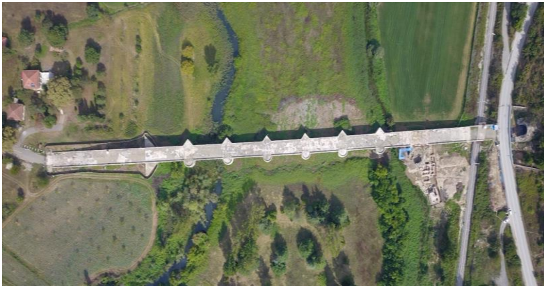
Resim 4.113. Sangarios Köprüsü selyaranları
