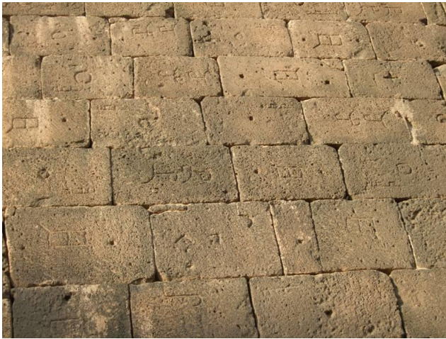
Resim 4.92. Dicle Köprüsü üzerinde bulunan taşçı işaretleri
