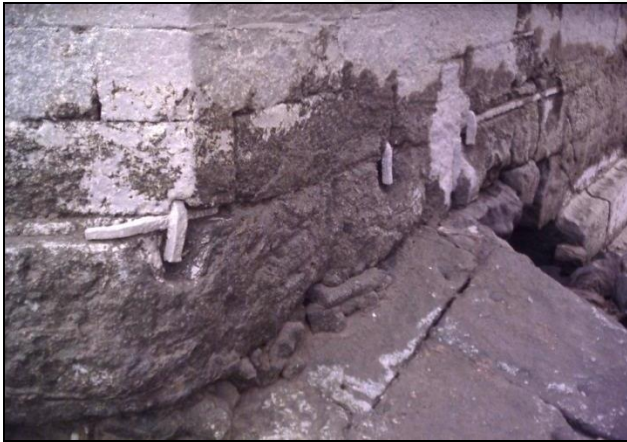
Resim 4.96. Adana İlindeki, Taşköprü'nün taş temel sistemi ve demir kenetlerle bağlantısı
