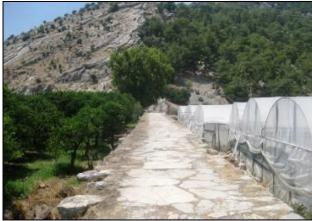
Resim 4.102. Alakır Köprüsü ve çevresi
