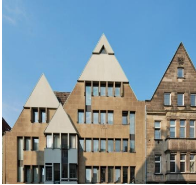
Şekil 2.26. Eski yapı, yeni yapı arasında konum benzerliğine bir örnek.
