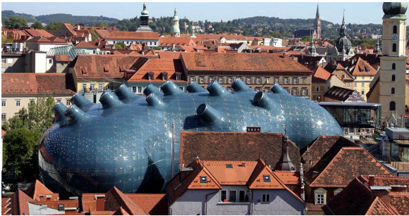
Şekil 4.12. Eski yapı, yeni yapı arasında biçimsel karşıtlığa bir örnek.
