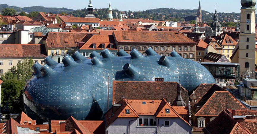
Şekil 2.39. Eski yapı, yeni yapı arasında biçimsel karşıtlığa bir örnek.
