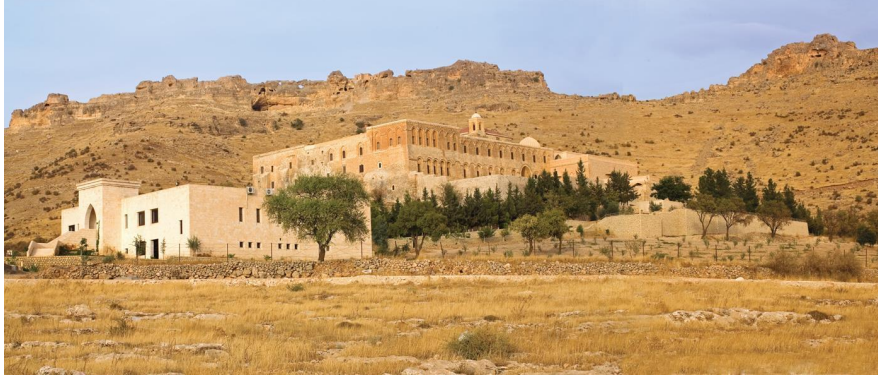
Şekil 2.25. Eski yapı, yeni yapı arasında doku benzerliğine bir örnek.
