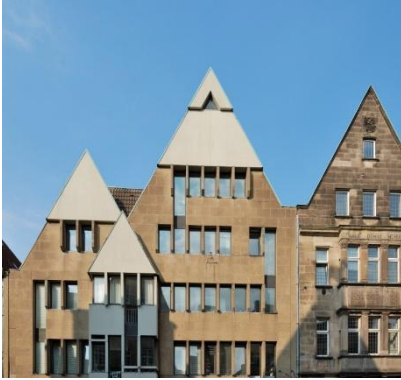
Şekil 4.10. Eski yapı, yeni yapı arasında konum benzerliğine bir örnek.
