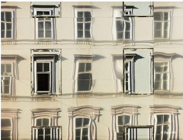
Şekil 4.14. Eski yapı, yeni yapı aralık karşıtlığına bir örnek.
