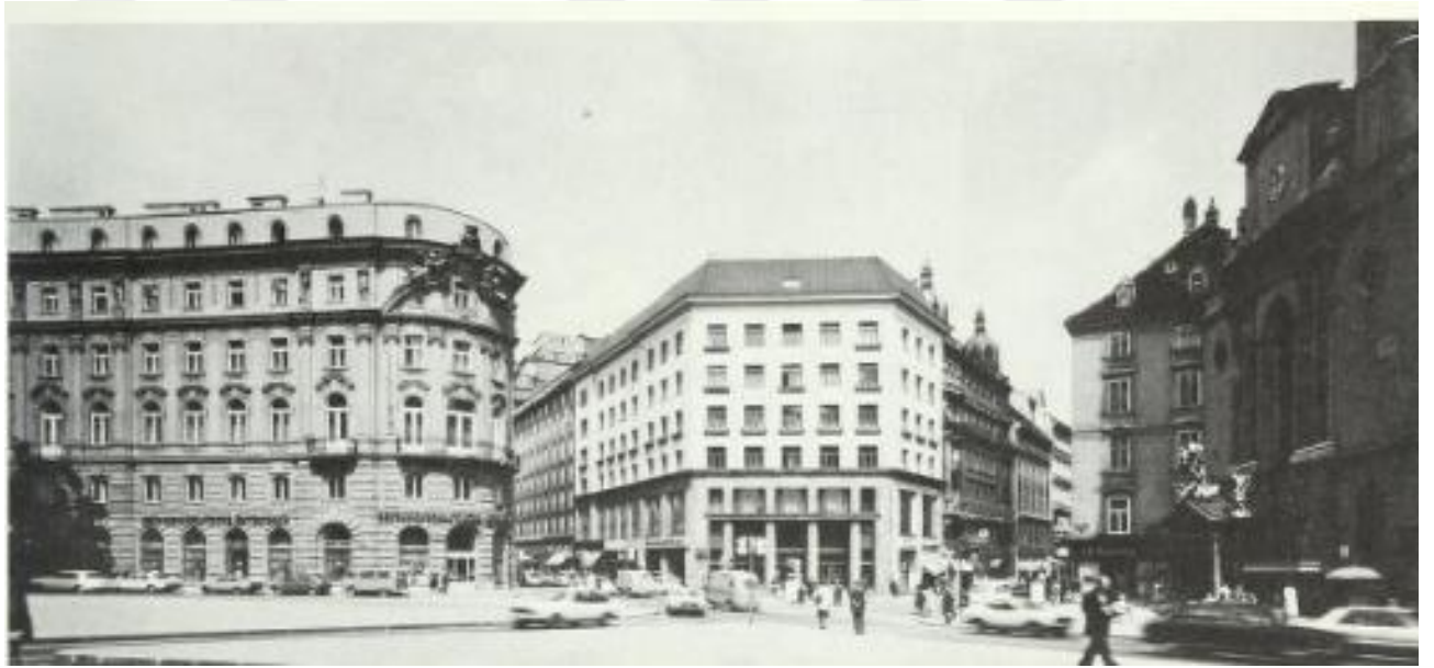
Şekil 2.28. Goldman ve Salatsch Binası (Brolin, 1980).
