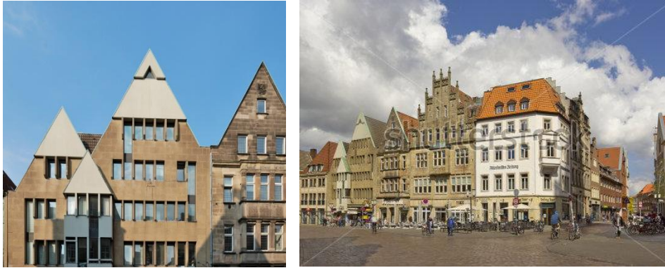
Şekil 4.6. Eski yapı, yeni yapı arasında biçimsel benzerlik.
