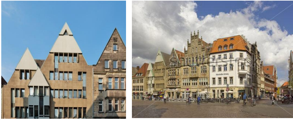
Şekil 2.22. Eski yapı, yeni yapı arasında biçimsel benzerlik.
