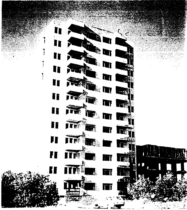
FOTO 11: Turunçgil Bahçesinde İnşa Edilmiş Çok Katlı Apartman (Kuzey Adana)
