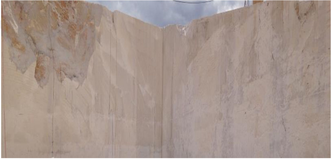
Şekil 4.7. Açık mermer işletmesinde iş sağlığı ve güvenliğine uygun olmayan ve düşmeye karşı herhangi bir önlem alınmamış yüksek kademe ve aynanın görünümü
