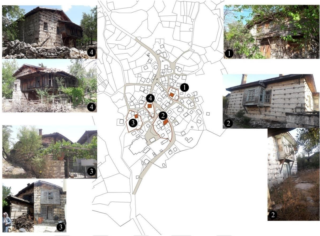
Şekil 4.45. Emiraşıklar Köyü tescilli yapıları
