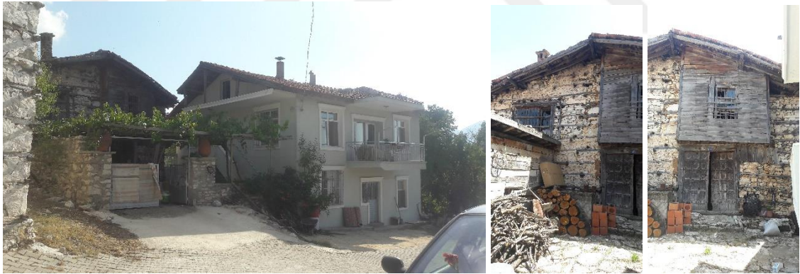
Şekil 4.46. Emiraşıklar, tescilli yapı bahçesine inşa edilmiş yeni yapı (Orijinal 2018)
