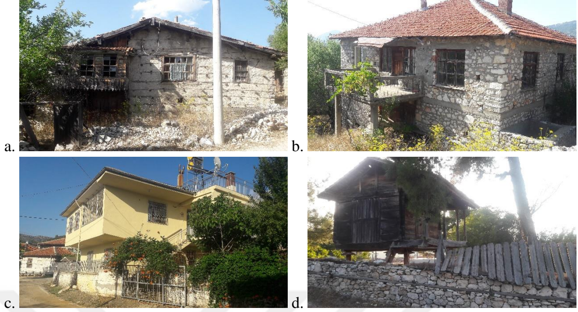
Şekil 4.38. a) Emiraşıklar Köyü düğmeli duvar sistemi ile üretilmiş yapı; b) yığma taş sistem ile üretilmiş yapı; c) betonarme karkas sistem ile üretilmiş yapı; d) ahşap karkas sistem ile üretilmiş yapı (Orijinal 2018)
