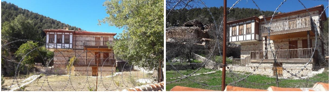
Şekil 4.52. Sarıhacılar, düğmeli duvar sistemi ile üretilmiş yeni yapı (Orijinal 2018)
