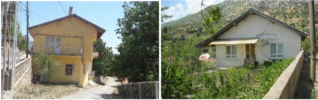
Şekil 4.49. Çimi, iki katlı inşa edilmiş yeni yapılar (Orijinal 2018)
