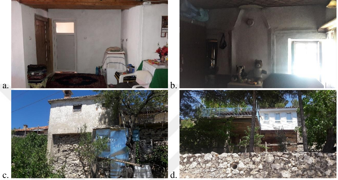
Şekil 4.94. a) Sofa mekanının bölünmesi ile oluşturulan ıslak hacim; b) oda duvarında bulunan ocak izi; c) ıslak hacim eki; d) teras eki (Orijinal 2018)
