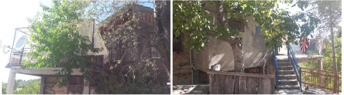
Şekil 4.41. Çimi, 130 ada 3 parseldeki tescilli yapının betonarme ekleri (Orijinal 2018)
