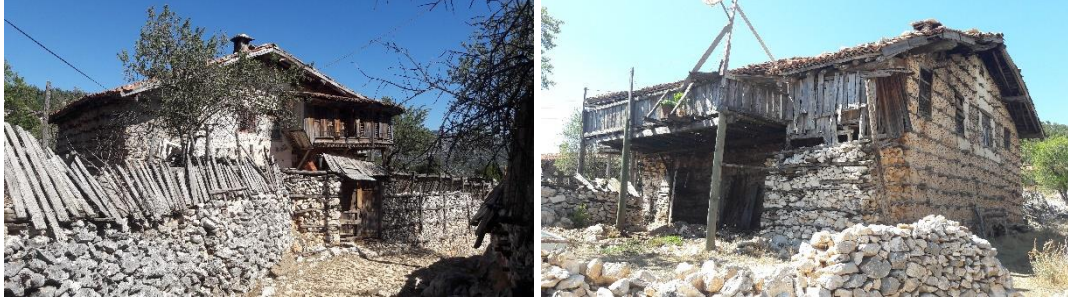
Şekil 4.36. Sarıhacılar Köyü düğmeli duvar ile inşa edilmiş yapılar (Orişinal 2018)
