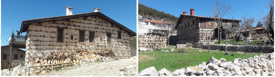
Şekil 4.64. Sarıhacılar Köyü strüktürel durumu iyi olan yapılar (Orijinal 2018)
