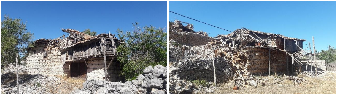
Şekil 4.66. Sarıhacılar Köyü harabe hale gelmiş yapılar (Orijinal 2018)
