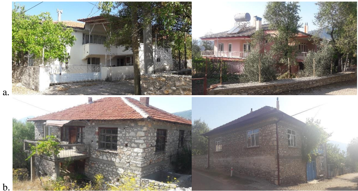
Şekil 4.55. a) Emiraşıklar, betonarme karkas sistem ile inşa edilmiş yapılar; b) taş yığma sistem ile inşa edilmiş yapılar (Orijinal 2018)
