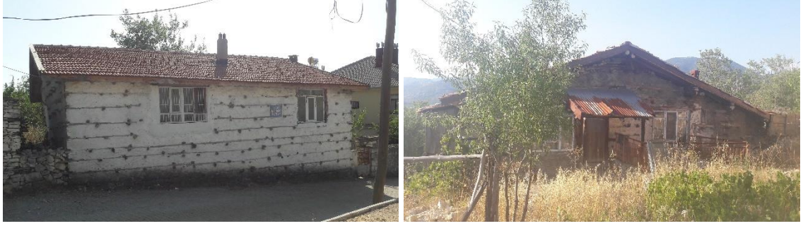
Şekil 4.85. Emiraşıklar Köyü pencere doğramaları değiştirilmiş yapılar (Orijinal 2018)
