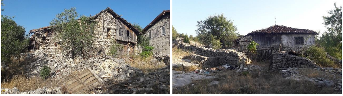
Şekil 4.69. Emiraşıklar Köyü harabe hale gelmiş yapılar (Orijinal 2018)
