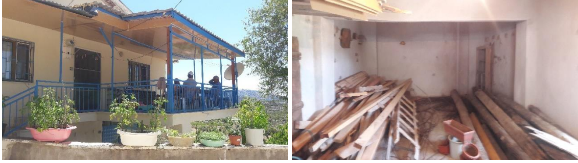
Şekil 4.34. Çimi Köyü düğmeli duvar ile üretilen zemin kat üzerine betonarme karkas sistem ile inşa edilmiş konut (Orijinal 2018)
