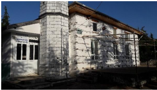
Şekil 4.23. Emiraşıklar Köyü camii (Orijinal 2018)
