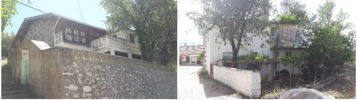
Şekil 5.2. Değiştirilmiş bahçe duvarları (Orijinal 2018)
