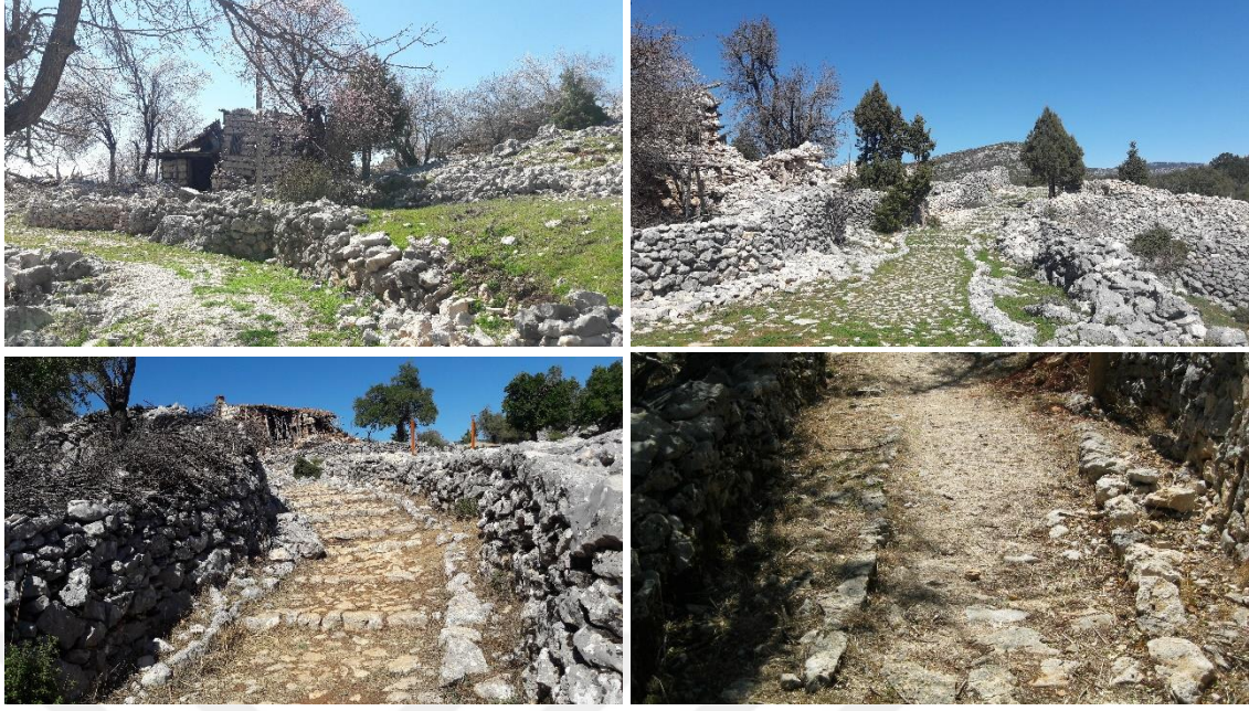
Şekil 4.12. Sarıhacılar Köyü sokak dokusu ve sınırlayıcı elemanlar (Orijinal 2018)
