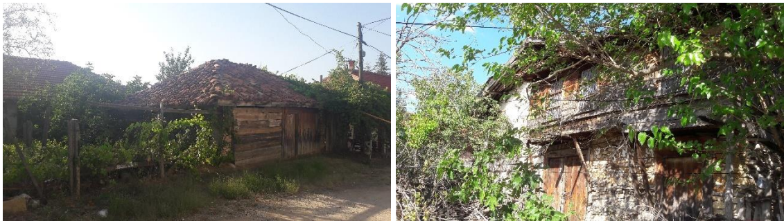
Şekil 4.68. Emiraşıklar Köyü strüktürel durumu orta olan yapılar (Orijinal 2018)
