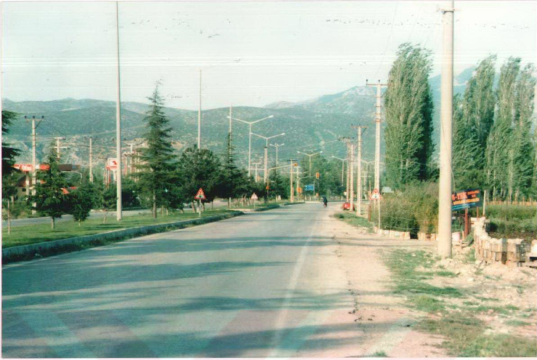
Şekil 5.1.3.1. Adnan Menderes Bulvarı orta refüj üzerindeki iğne yapraklı ağaç türlerinin araç ışıklarını önlemeye yönelik tesis edilmesi
