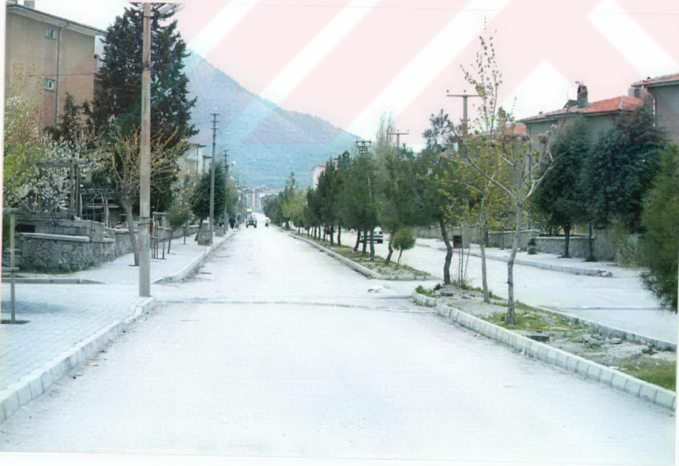
5.2.4. Atatürk Bulvarına bağlı tali yol kaldırımı ve orta refüjde tesis edilen iğne yapraklı ağaç türlerinin yanlış seçilmesi ve sık dikilmesi.
