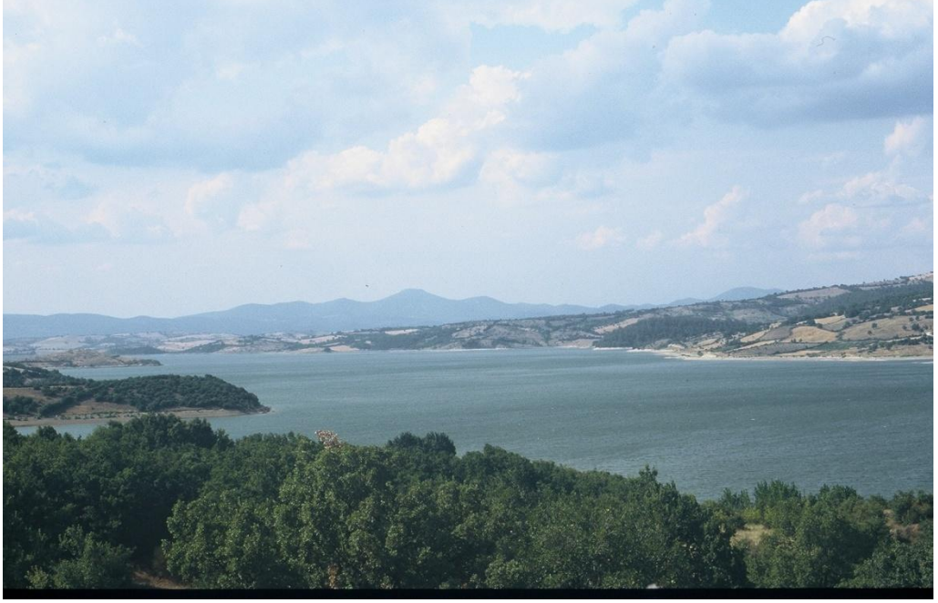
R.1. DSI Barajı ve çevresi
