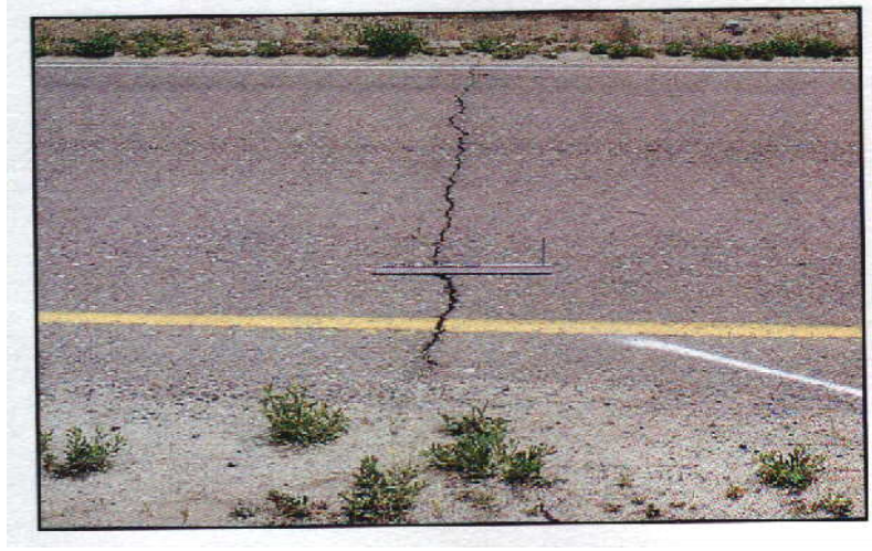
Şekil 3.32. Yüksek önemli enine kırılma
