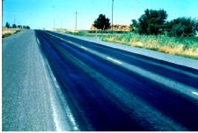
Şekil 3.36. Yüksek önemde kumada açıkça görülen tekerlek izleri
