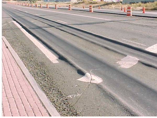
Şekil 3.29. Tekerlek izinde orta önemde boyuna kırılma
