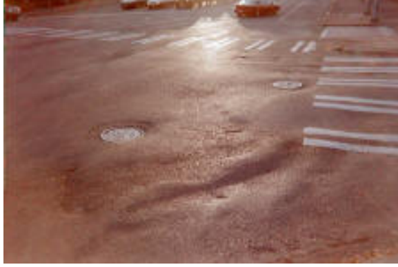
Şekil 3.35. Ondülasyon ve yığılma
