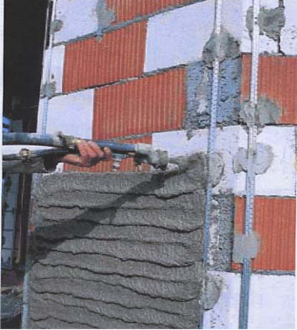
Şekil 2.3.1.4. Selüloz eter içeren bir makine sıvasının duvara uygulanişı (Clariant, 2003)
