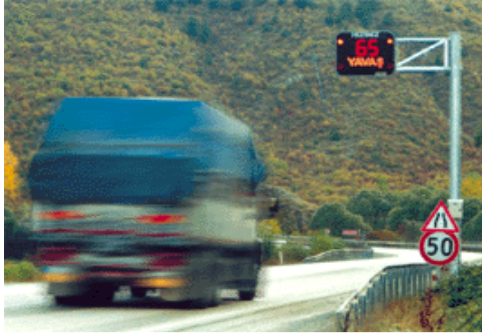
Şekil 2.5.1. Bolu-Karabük yolu doppler radarlı hız ikaz sistemi (Ortana, 2002)
