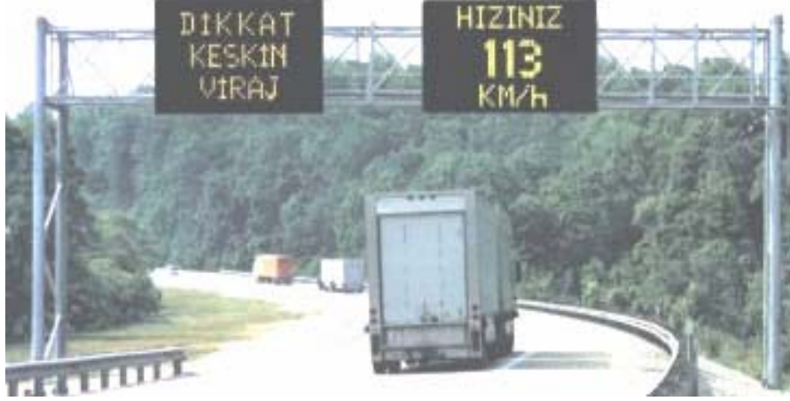
Şekil 2.5.4. Bir değişken mesaj işaretli hız ikaz sistemi (Ultra web sitesi, 2002)
