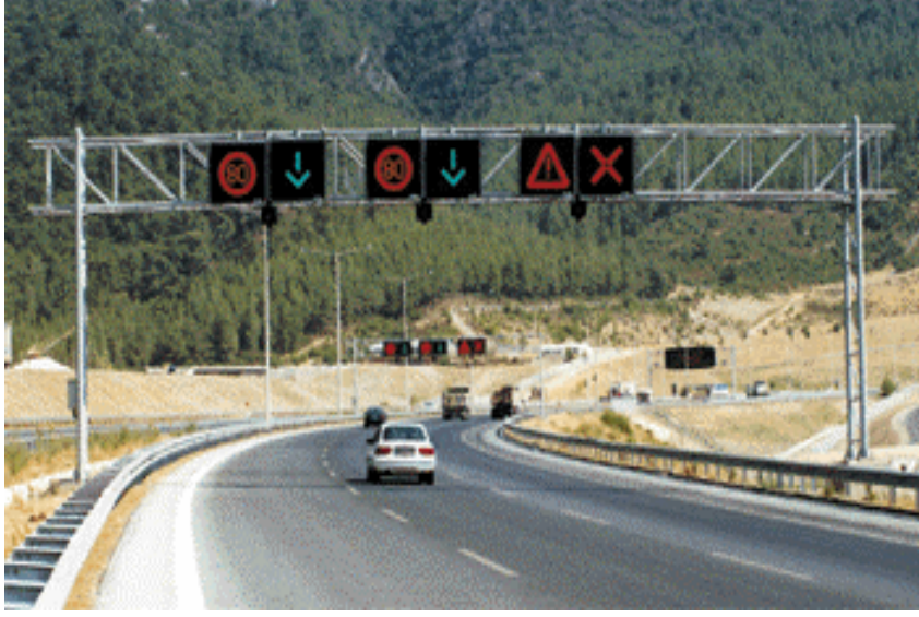
Şekil 2.5.5. Selatin tüneline araç hızını ve hız limitini gösteren DMİ (Ortana, 2002)
