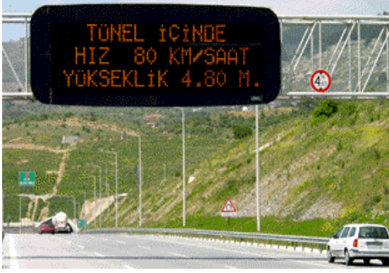
Şekil 2.5.3. İzmir-Aydın Otoyolu, Selatin Tüneli değişken mesaj işaretleri (Ortana)
