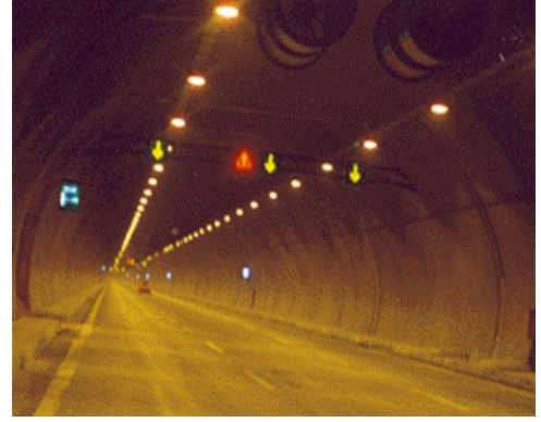
Şekil 2.5.3. İzmir-Aydın Otoyolu, Selatin Tüneli değişken mesaj işaretleri (Ortana)
