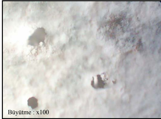
Şekil 4.49. % 10 Amorf silika kullanımı ile ASR etkisinde betonda oluşan yüzeysel bozunma
