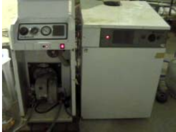
Ek 1.2. Sıcak su temininde kullanılan atmosferik gaz brülörlü ve üflemlü mazot brülörlü sıcak su kazanları.
