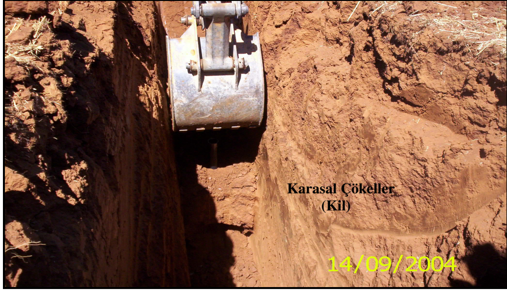
Şekil 4.21. Açılan araştırma çukurundan bir görünüm (AÇ5)
