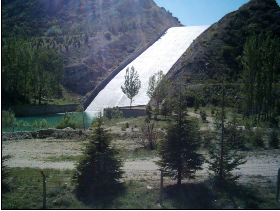
Şekil 4.15 : Uluborlu Barajı'nın teknik özellikleri ve mansaptan bir görünümü
