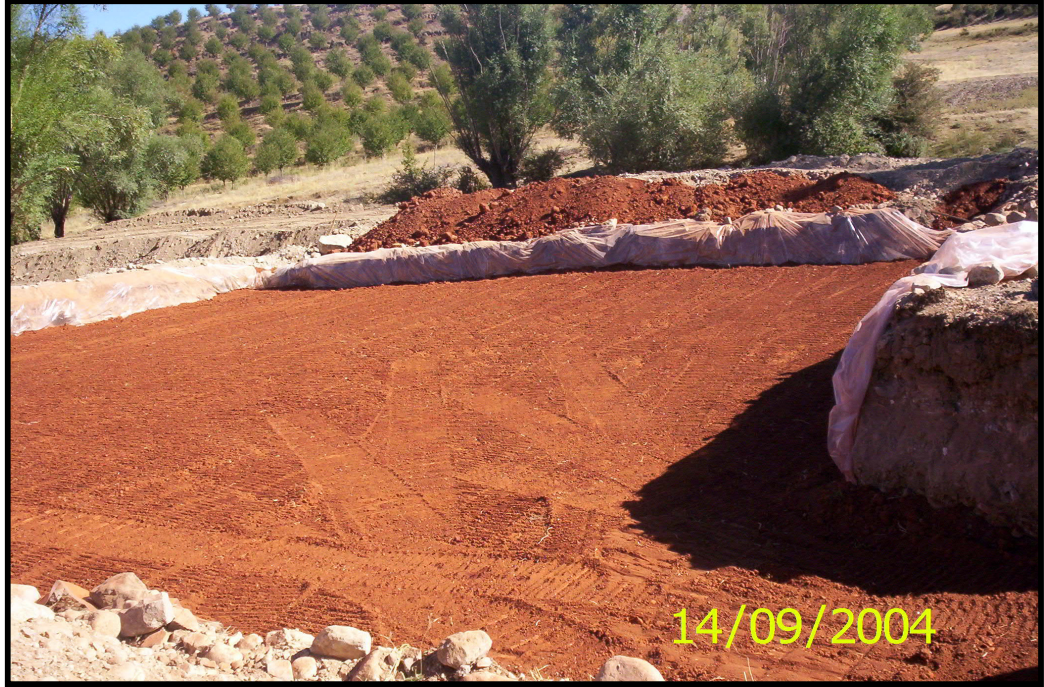
Şekil 4.28: İleğidağı Köyü atık su arıtma tesisi taban sızdırmazlık çalışmaları.
