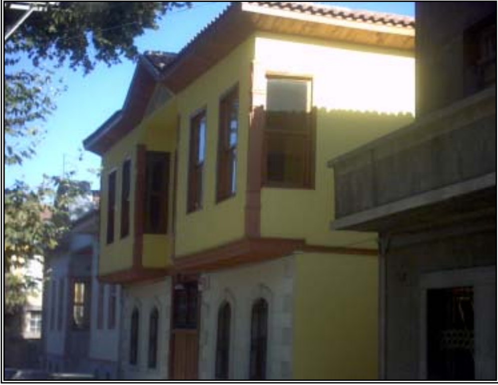
Şekil 4.2.12. Damgacı Sokak 41 T. Nolu Binanın Restorasyon Sonrası Görünümü (Fotoğraf: Kayalı,B. 2004)
