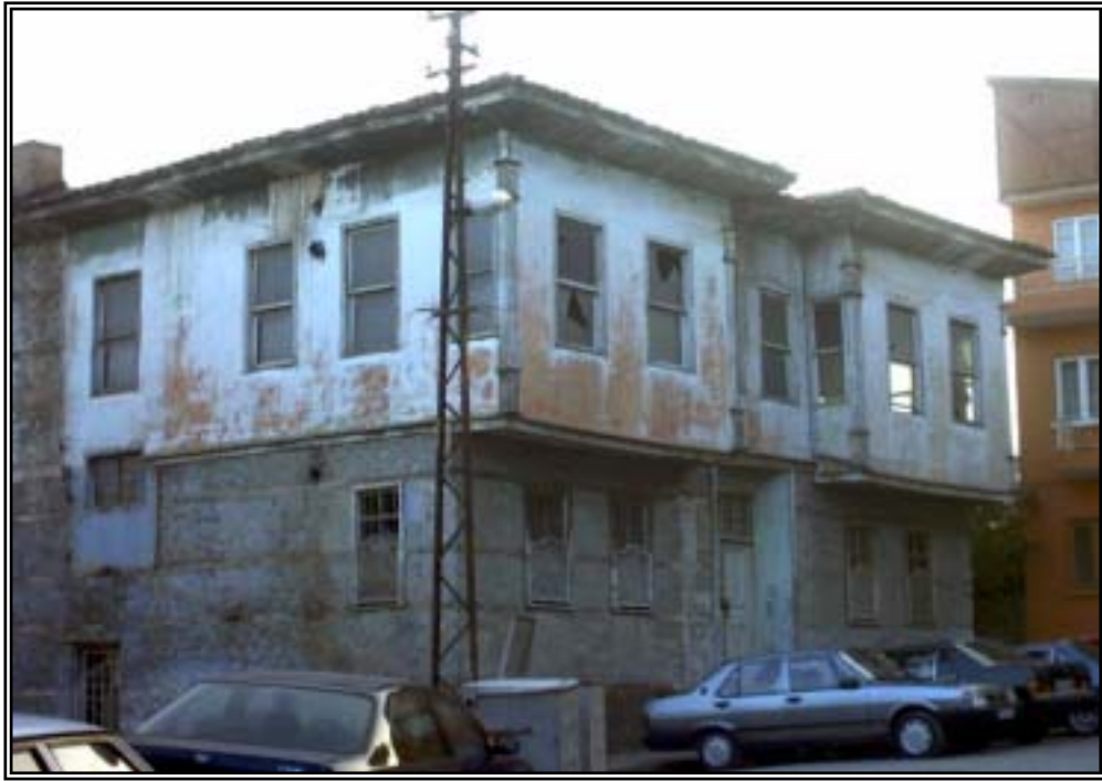
Şekil 5.2.1. Ethem Hacı Ethemoğlu Evi Giriş Cephesinden Görünüm (Fotoğraf: Kayalı,B. 2004)
