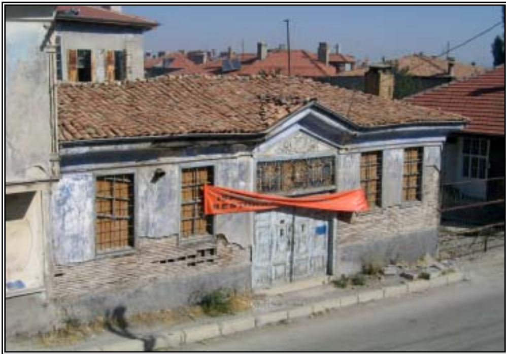
Şekil 4.2.23. Kepeci Mahallesi 53 T. Nolu Binanın Restorasyon Öncesi Görünümü (Fotoğraf: Kayalı,B. 2004)
