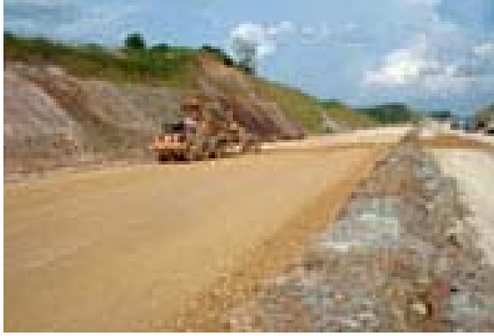
Şekil 0.2. Alttemel tabakası yapım aşaması
