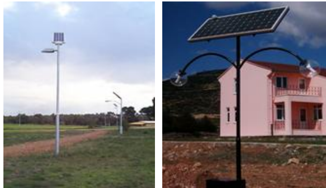
Şekil 3.32. Güneş pili çevre aydınlatma sisteminden görünüm.
