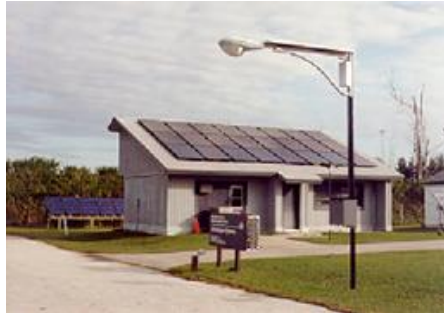
Şekil 3.43. Güneş pilli ups / yedek güç sistemleri.
