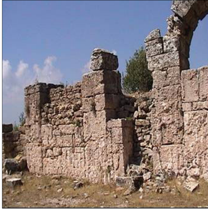
Şekil 3.17. Kremna - Hamamın Doğu Tarafından Görünüşü (T24 Tuğla ve M14 Harç Numunelerinin Alındığı Yer)
