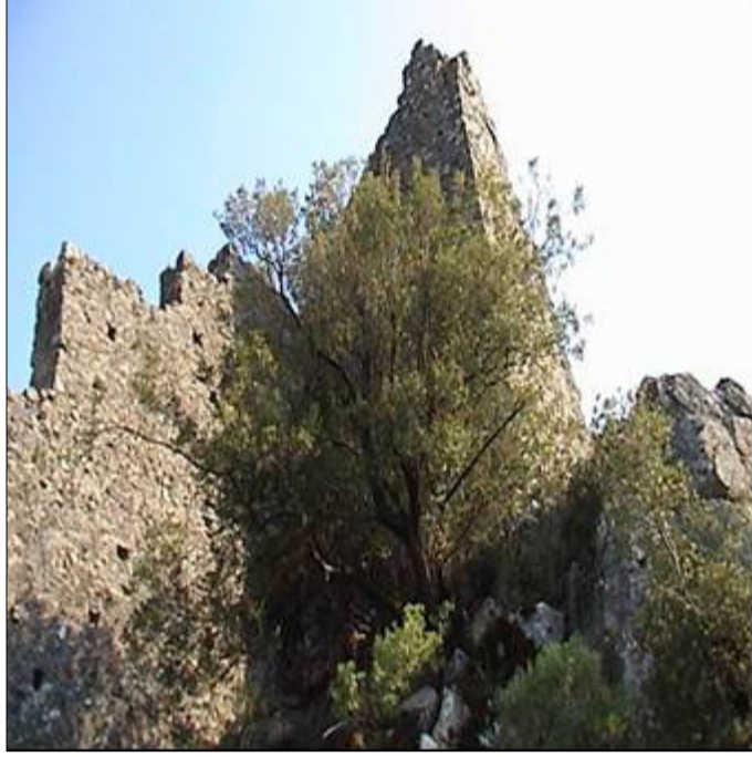
Şekil 3.6. Sığırlık Harabesi - Kale I (M3 Harç ve T41 Tuğla Numunelerinin Alındığı Yer)
