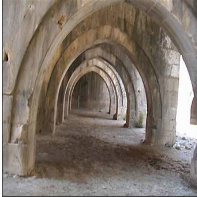
Şekil 3.19. Kervansarayın İç Görünüşü (S41 Taş ve M25 Harç Numunelerinin Alındığı Yer)
