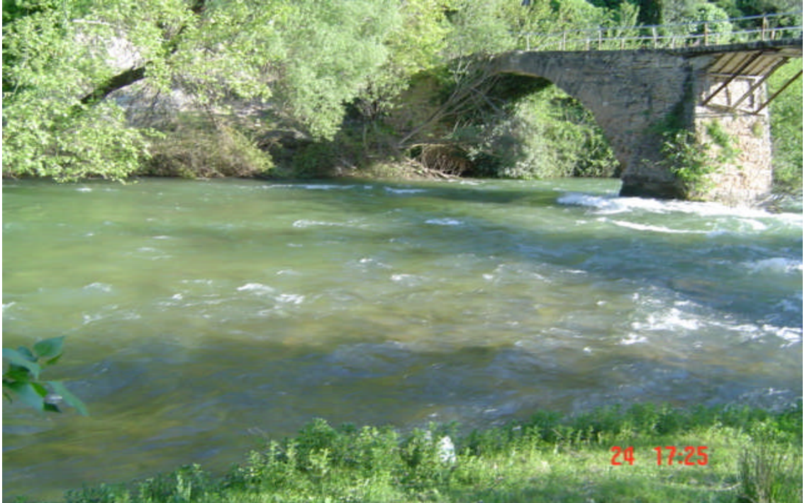
EK.2.4. 4 nolu Güney-Yenicekent istasyonu
