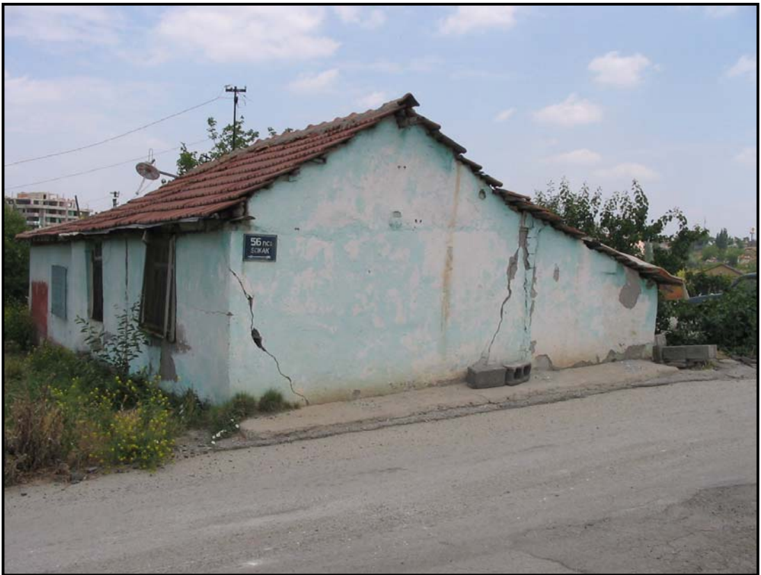
Şekil 4.6. Ankara kilindeki bir gecekonduda, şişme potansiyeline bağlı olarak değişik yönlerde gelişmiş çatlaklar (Balgat)
