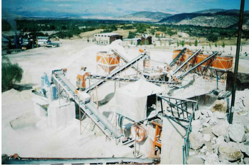
Şekil 3.3. Atık betonun kırıldığı tesis
