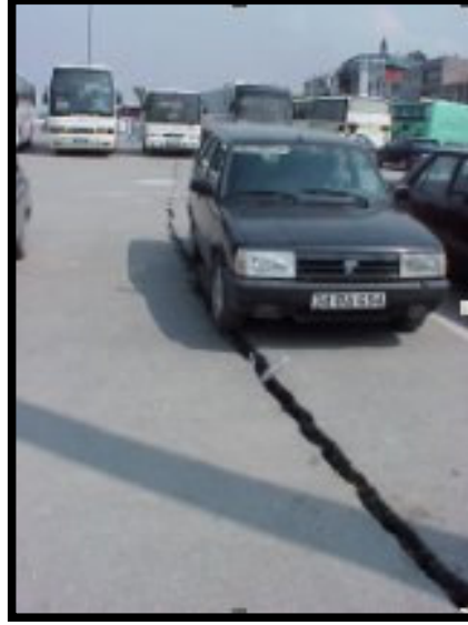
Şekil 2.4 Yerin salınımı sonucu oluşan sıvılaşma deformasyonu
