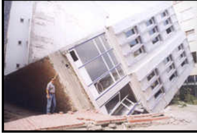
Şekil 2.1.Sıvılaştırma sonucu olarak taşıma gücü kaybına Marmara depreminden bir örnek
