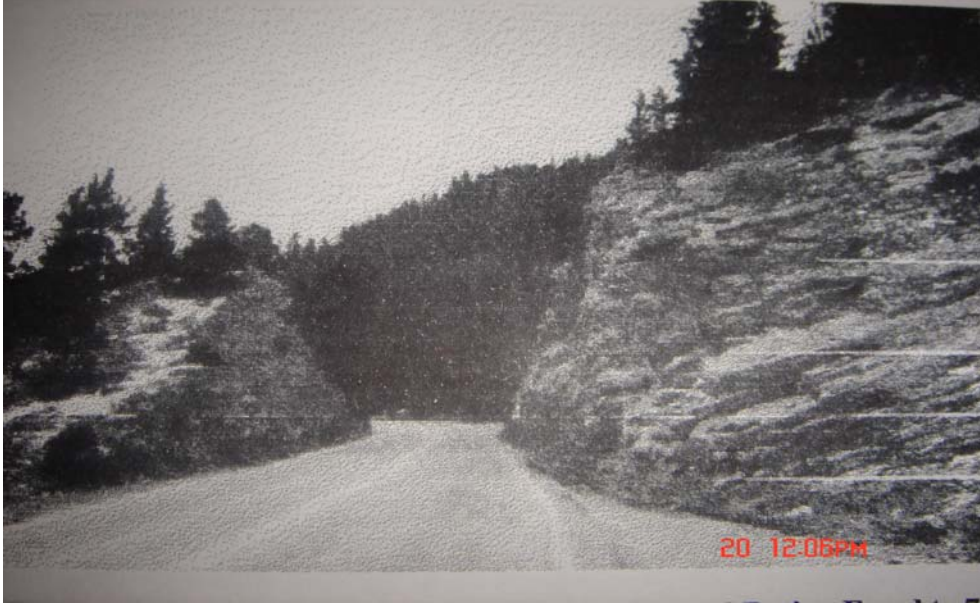
Şekil 2.12. Karayolu kenarı tehlike oranı 7 olan şehirlerarası bölünmemiş tipik bir karayolu (Zegeer vd., 1987)
