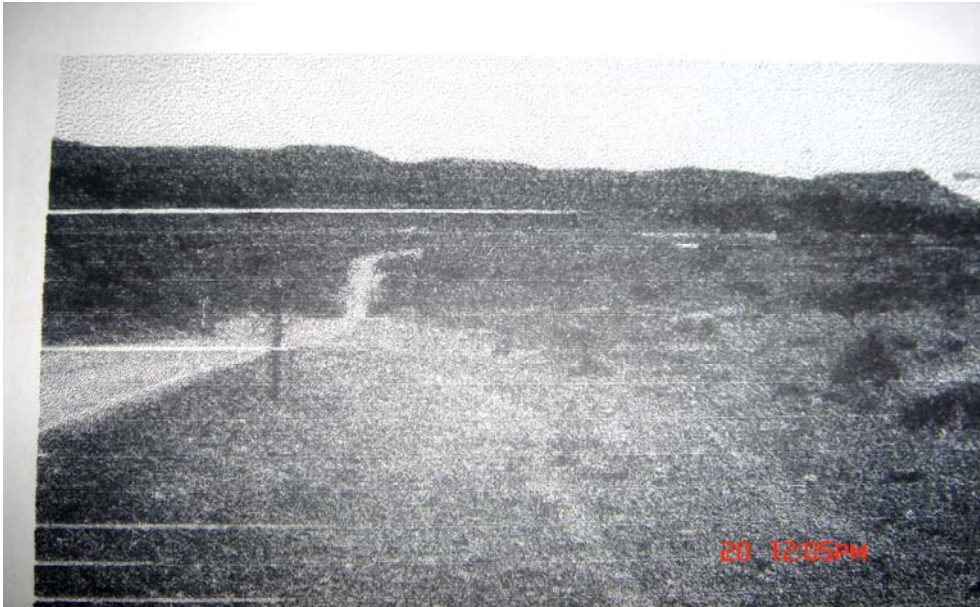
Şekil 2.7. Karayolu kenarı tehlike oranı 2 olan şehirlerarası bölünmemiş tipik bir karayolu (Zegeer vd., 1987)
