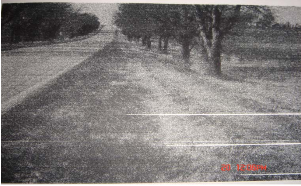
Şekil 2.10. Karayolu kenarı tehlike oranı 5 olan şehirlerarası bölünmemiş tipik bir karayolu (Zegeer vd., 1987)
