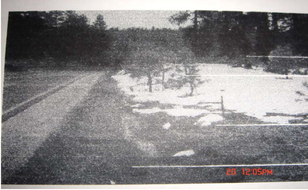
Şekil 2.8. Karayolu kenarı tehlike oranı 3 olan şehirlerarası bölünmemiş tipik bir karayolu (Zegeer vd., 1987)
