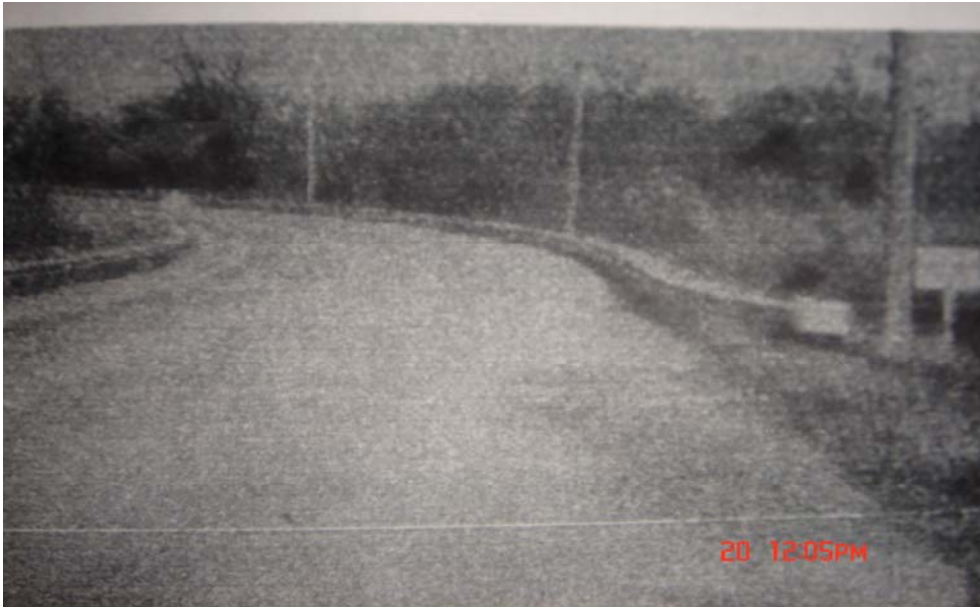
Şekil 2.9. Karayolu kenarı tehlike oranı 4 olan şehirlerarası bölünmemiş tipik bir karayolu (Zegeer vd., 1987)
