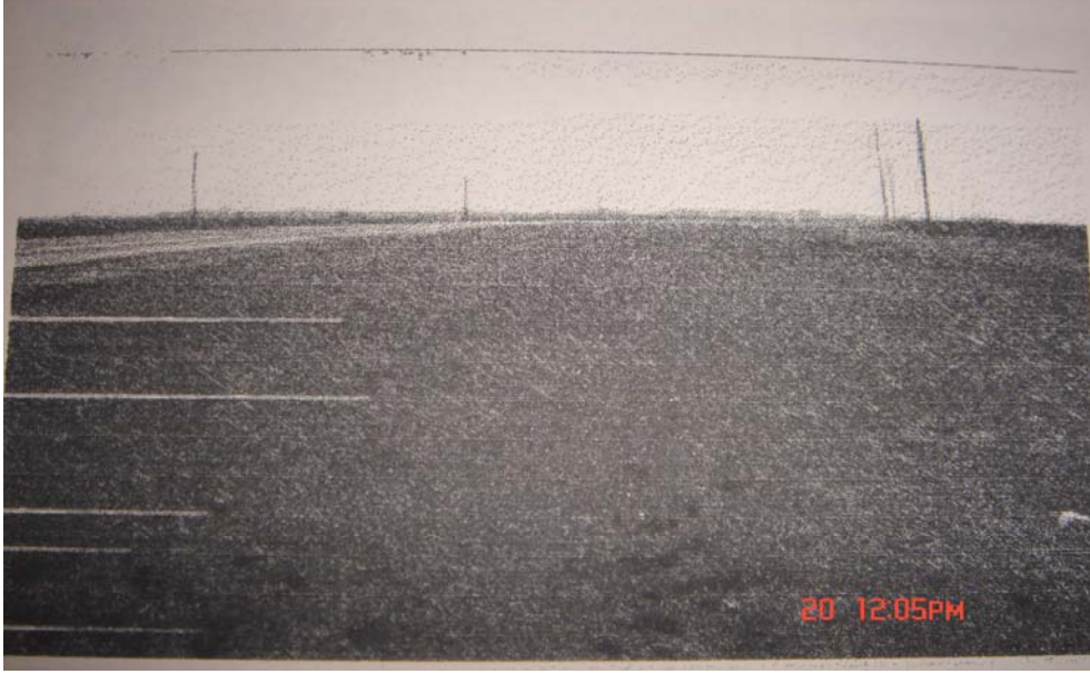
Şekil 2.6. Karayolu kenarı tehlike oranı 1 olan şehirlerarası bölünmemiş tipik bir karayolu (Zegeer vd., 1987)
