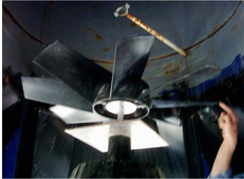
Şekil 3.13. Bacanın alt kısmına yerleştirilen pervane
