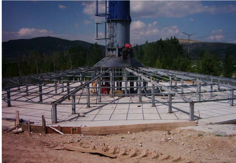
Şekil 3.11. Kollektör ve bacanın montaj aşaması
