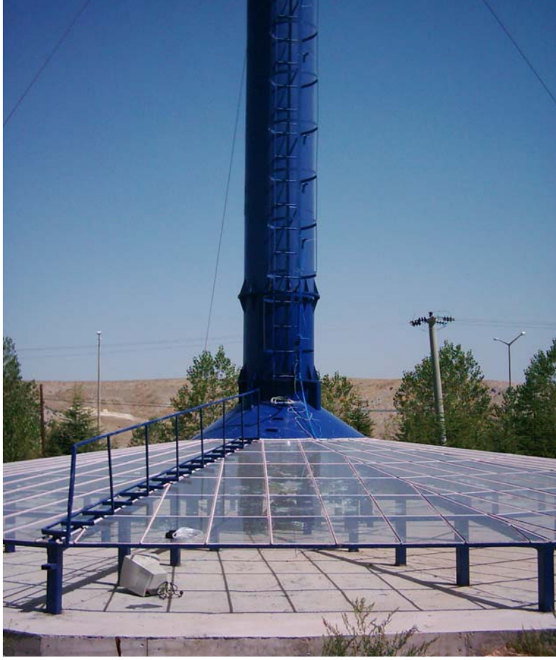
Şekil 3.12. Kollektör cam örtü malzemesinin yerleştirilmesinden sonraki görüntü
