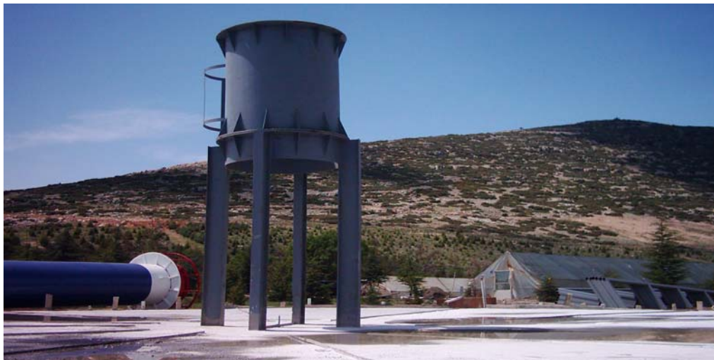
Şekil 3.9. Baca ayağının zemine monte edilmiş durumu
