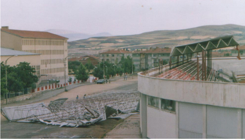
Şekil 3.14. Döküm düğüm sistemli bir uzay kafes sistem
