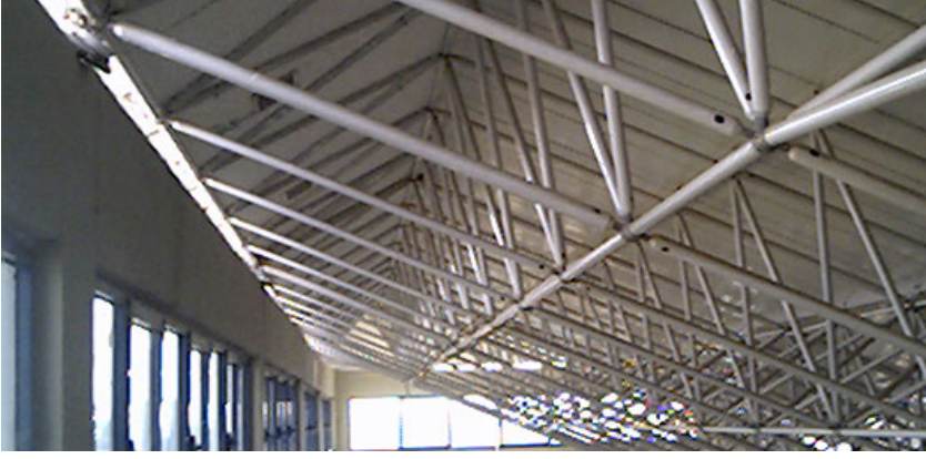
Şekil 3.13. Dolu küre düğüm bir uzay kafes uygulama
