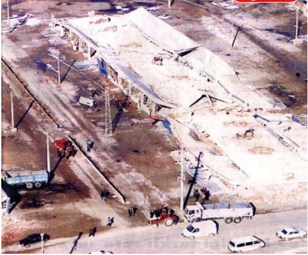
Şekil 4.14. Çay ilçesinde tümü göçen tek katlı sanayi yapıları (Çelebi ve Saatcıoğlu, 2002)
