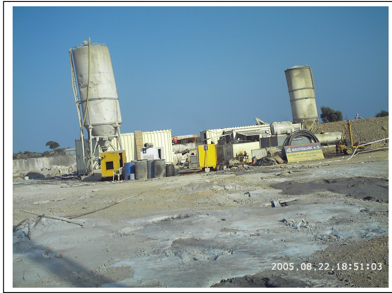
Şekil 2.8. Jet grout çimento silosu, pompa ve santral üniteleri
