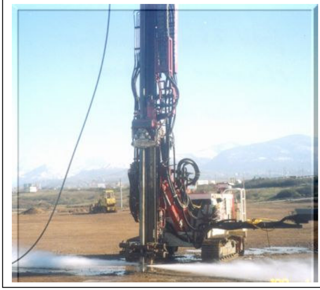
Şekil 2.9. Jet grout delgi makinesi (SM-405)
