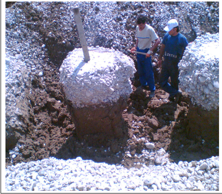
Şekil 4.6. İstanbul oteli lojmanları inşaatı jet grout test kolonları
