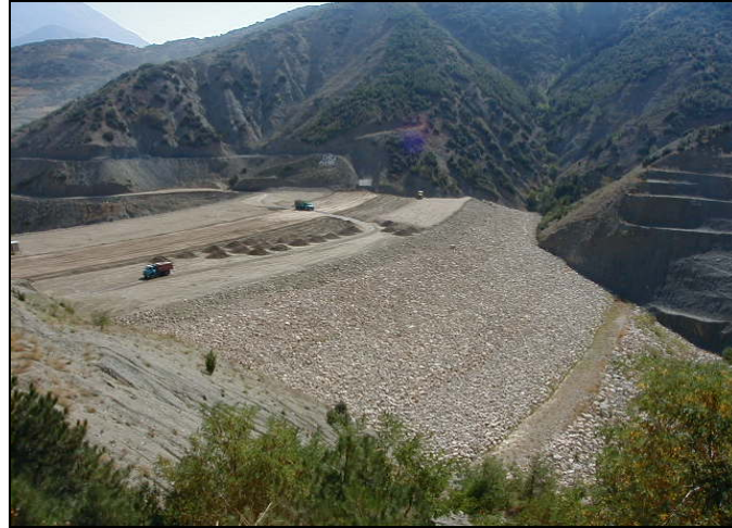
Şekil 4. 7. Darıdere Barajının genel görünümü
